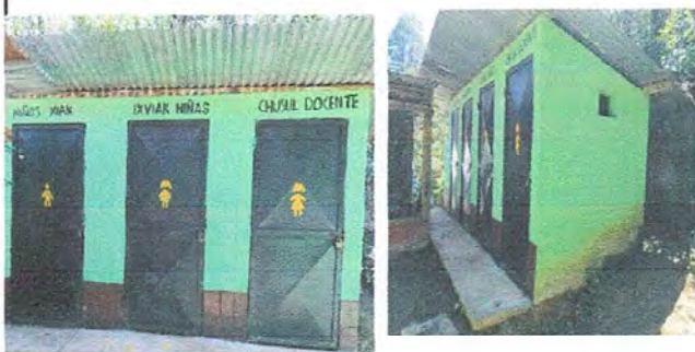
Foto 15 Modulo 3: Mantenimiento a estructura de puerta (lijado, cambio de tubo, cepillado, sujeciones, aplicación de pintura)
