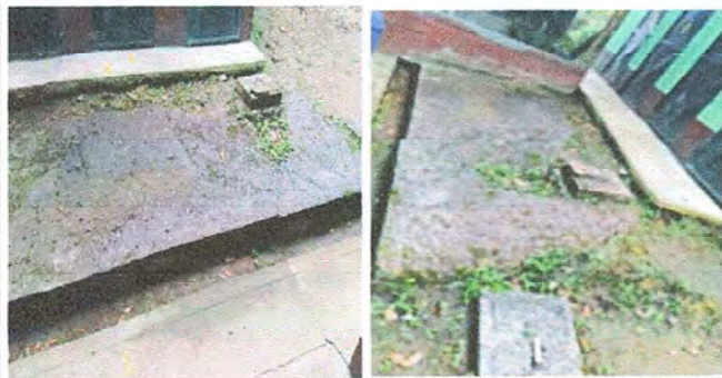
Foto 13: Modulo 3: Sustitución de piso de torta de concreto
