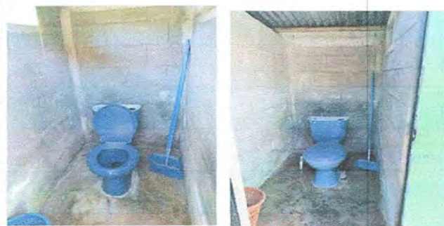
Foto 14: Modulo 3: Sustitución de inodoro
