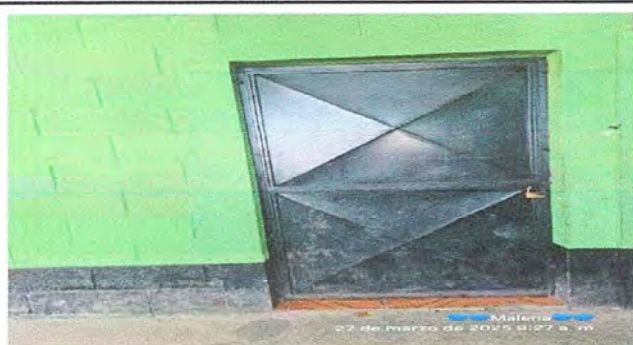
Foto 9: Módulo 2: Sustrucción, fabricación e instalación de puerta de cocina
