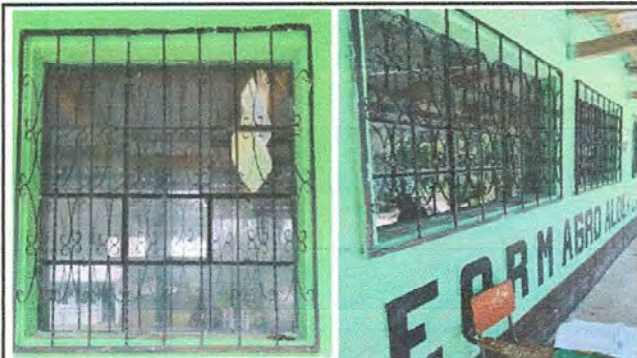
Foto 1 Modulo: 1 Sustitución de ventanas de metal por PVC mas vidrio
