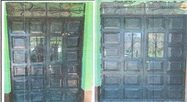
Foto 4 Modulo 1: Sustitución, Fabricación e instalación de puertas de aulas
