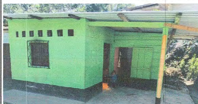
Foto 8: Módulo 2: Pintura en muros exteriores e interiores
