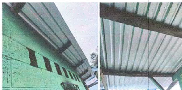
Foto 6 Modulo 2: Sustitución de estructura de soporte de madera, por metal
