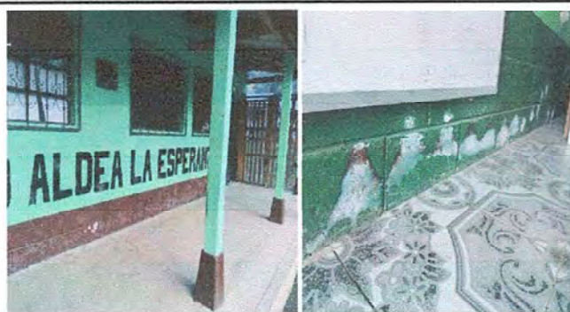
Foto 3 Modulo 1: Pintura en muros exteriores e interiores
