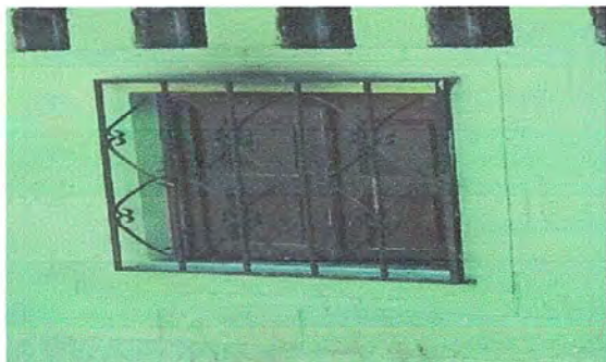
Foto 7 Módulo: 2 Sustrucción de balcón de metal
