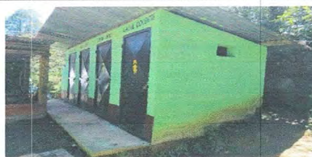
Foto 12: Módulo 3: Pintura en muros exteriores e interiores
