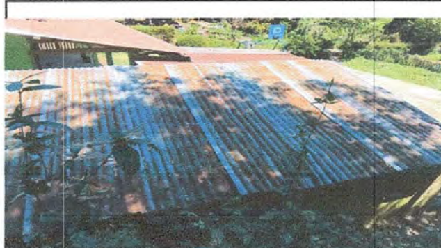
Foto 10 Módulo: 3: Sustrucción de lámina, por lámina troquelada aluzinc calibre 25
