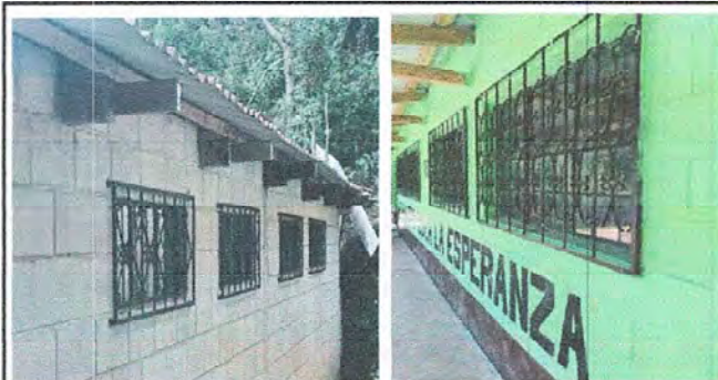
Foto 2 Modulo 1: Sustitución de balcon de metal
