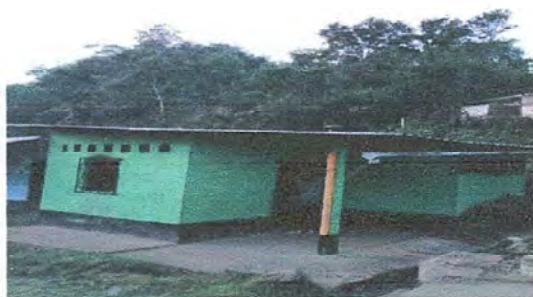
foto 5 Modulo 2: Sustitución de lámina, por lámina troquelada aluzinc calibre 26
