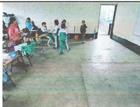
Foto 2: MODULO 1: SUSTITUCIÓN DE PISO DE TORTA DE CONCRETO POR PISO CERAMICO.
