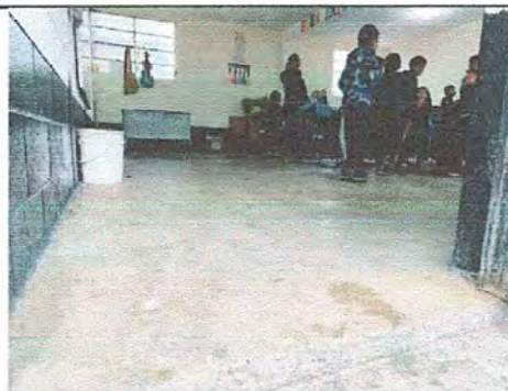
Foto 4: MODULO 1: SUSTITUCIÓN DE PISO DE TORTA DE CONCRETO POR PISO CERAMICO.
