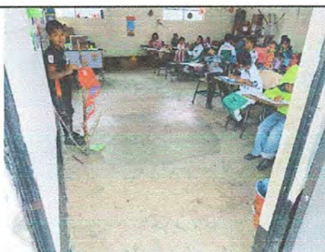
Foto 5: MODULO 1: SUSTITUCIÓN DE PISO DE TORTA DE CONCRETO POR PISO CERAMICO.
