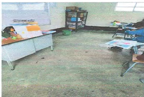
Foto 1: MODULO 1: SUSTITUCIÓN DE PISO DE TORTA DE CONCRETO POR PISO CERAMICO.
