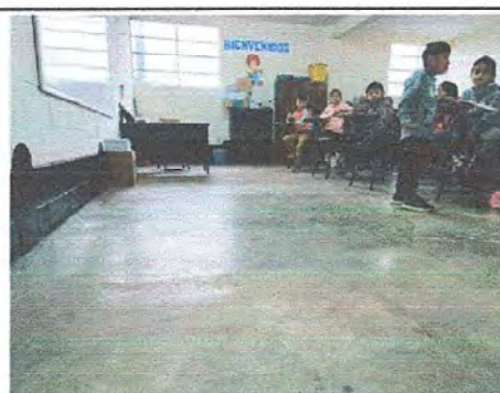
Foto 6: MODULO 1: SUSTITUCIÓN DE PISO DE TORTA DE CONCRETO POR PISO CERAMICO.
