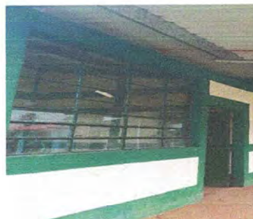
MODULO 4 Foto 10: suministro e instalación de balcones de metal
