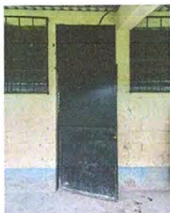
MODULO 1 Foto 3: Mantenimiento a estructura de puertas (lijado, cambio de tubo, cepillado, sujeciones aplicación de pintura)
