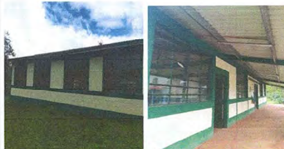
MODULO 3 Foto 8: suministro e instalación de balcones de metal
