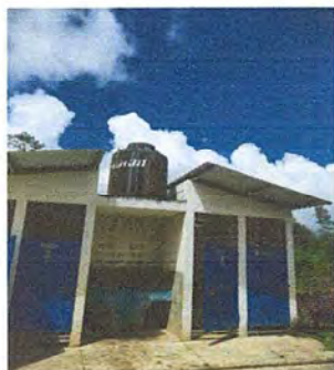
MODULO 2 Foto 7: Sustitución de accesorios deposito de agua y sustitucion de llave de paso
