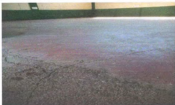
MODULO 4 Foto 9: Sustitución de piso de cemento liquido por ceramico
