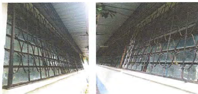
MODULO 1 Foto 4: Sustitución de vidrios
