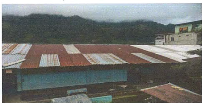
FOTO 1. Modulo 1. Sustitucion de lámina por lámina troquelada aluzinc cal 26.
