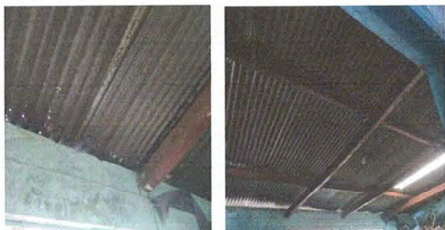
FOTO 3. Modulo 3. Sustitucion de lamina por lamina troquelada aluzinc cal 26. Sustitucion de estructura de soporte de madera por metal.
