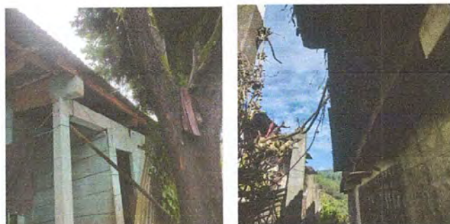
FOTO 4. Modulo 3. Sustitucion de bajada de agua pluvial de pvc 3". Sustitucion de canal de metal
