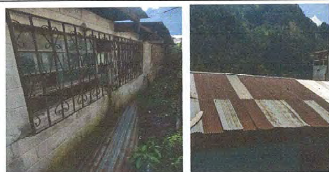
FOTO 5. Modulo 3. Sustitucion de ventanas de metal por pvc. Sustitucion de capote de lamina para lamina troquelada
