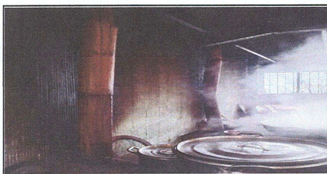
Foto 5: MODULO III, Sustitución de chimenea de concreto
