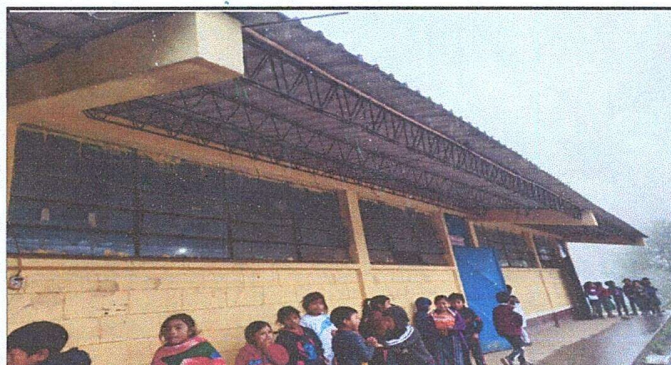
Foto 4: MODULO II, Sustitución de balcones de metal
