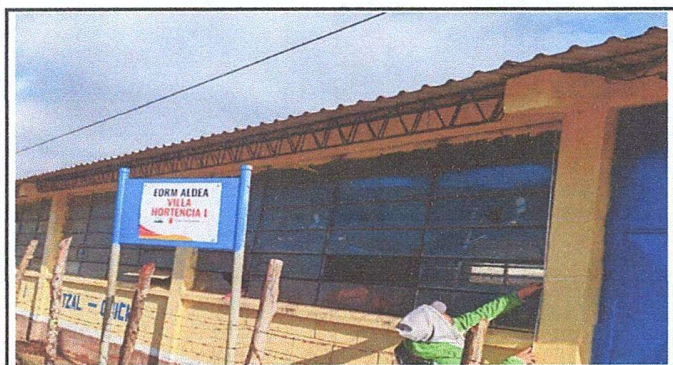
Foto 3: MODULO II, Sustitución de balcones de metal
