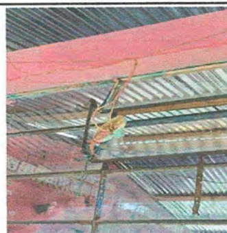
Foto 6: MODULO 1 SUSTITUCION DE PLAFONERA
