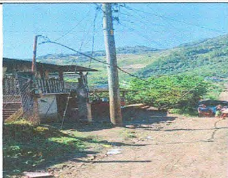
Foto2: MODULO 2 Instalacion de acometida electrica
