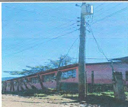
Foto1: MODULO 1 Instalacion de acometida electrica
