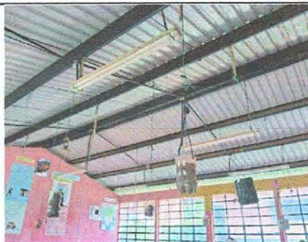
Foto 13: MODULO 2 SUSTITUCION DE FOCOS AHORRADORES
