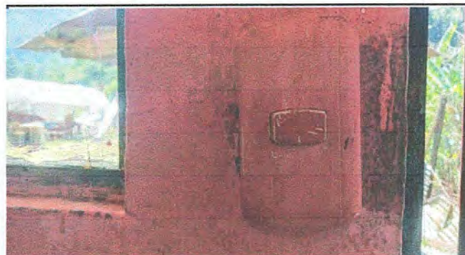
Foto 4: MODULO 1 SUSTITUCION DE INTERRUPTORES
