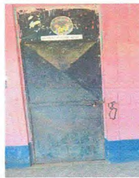
Foto 10 MODULO 1 SUSTITUCION DE PUERTA DE METAL
