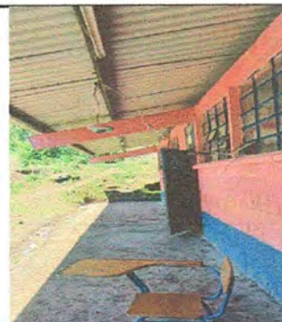
Foto 17: MODULO 2 SUSTITUCION DE PLAPONERA
