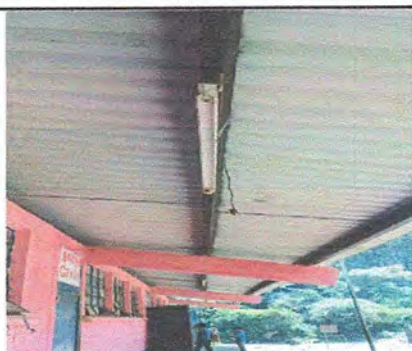
Foto 16: MODULO 2 REPARACION DE CABLEADO ELECTRICO
