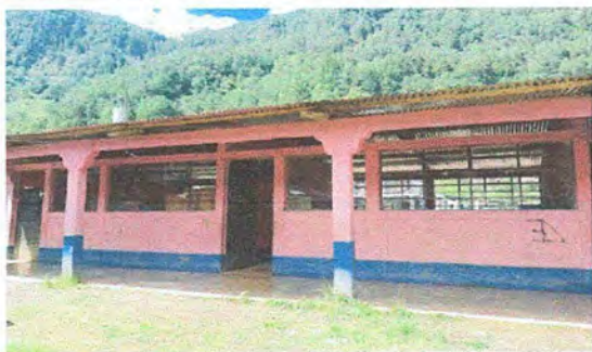
Foto 11 MODULO SUMINISTRO E INSTALACION DE BALCONES
