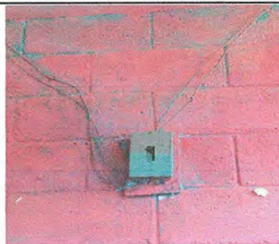
Foto 8: MODULO 1 SUSTITUCION DE TABLERO DE FILIPONES
