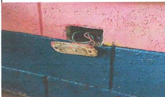
Foto 14: MODULO 2 SUSTITUCION DE TOMACORRIENTES DOBLE
