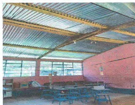
Foto 2: MODULO 1 SUSTITUCION DE FOCOS AHORRADORES
