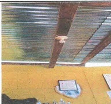
FOTO 9 MODULO: 1 SUSTITUCION DE DUCTO ELECTRICO + ACCESORIO
