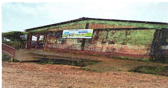
Foto 3: MODULO 1: Repello en muro. Cernido en muro
