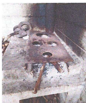
Foto 3: MODULO II, Sustitución de plancha de metal de 3 hornilla.
