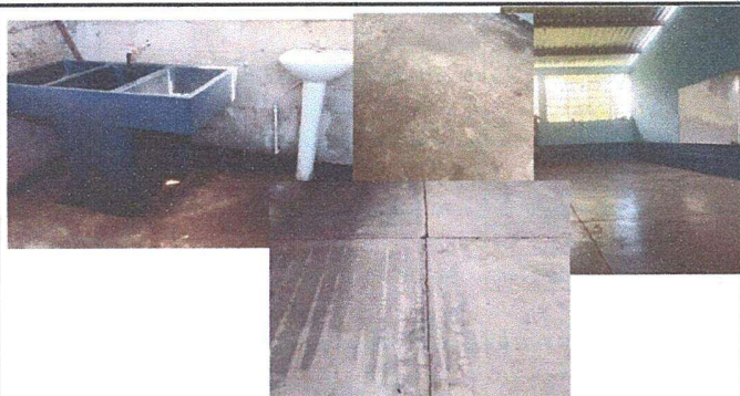
Foto 1: MODULO I, Sustitución de piso de cemento líquido por cerámico
