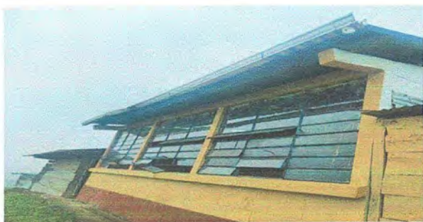
Foto 5: MODULO 3 sustitucion de canales.
