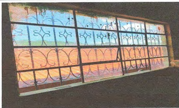
Foto 3: MODULO 2 sustitucion de ventanas de metal por por ventanas pvc
