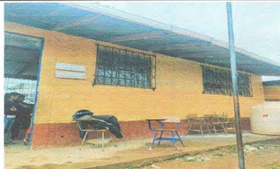
Foto 2: MODULO 1 pintura en muros interiores y exteriores
