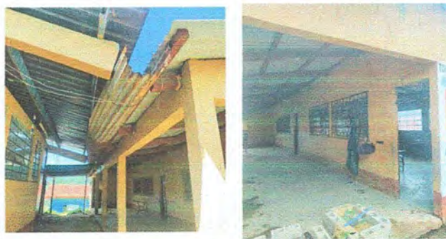
Foto 4: MODULO 2 pintura en muros interiores y exteriores
