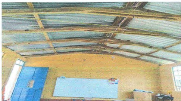
Foto1: MODULO 1. sustitucion de lámina y sustitucion de estructura de madera por metal
