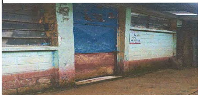
modulo1 : foto 1 Sustitucion puertas
