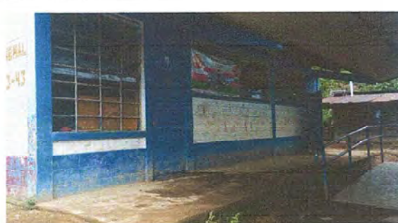
modulo 1 Foto 4: suministro de bajada de agua pluvial de metal por tuvo pvc 3"
