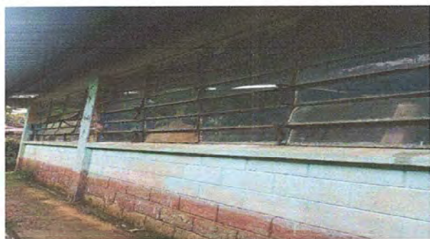
modulo 1 Foto 3: Suministro e instalacion de balcones para ventana
