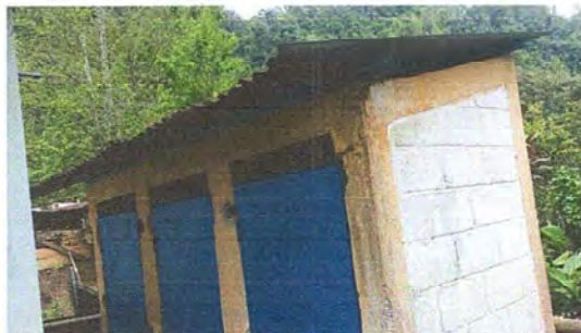
modulo 2 foto 7: sustitucion de lamina por lamina troquelada aluzinc calibre 26
