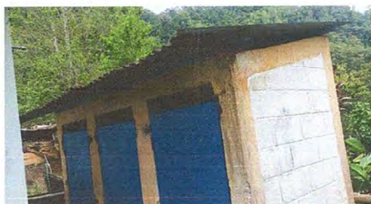
modulo 2 foto 11: desinstalacion de estructura portante.
