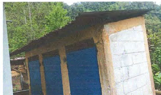
modulo 2 foto 8: sustitucion de puertas en servicios sanitarios
