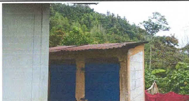
modulo 2 foto 9 sustitucion de elementos de fijacion tornillos
