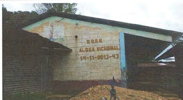
modulo 1 Foto 5: pintura en muro exteriores e interiores
