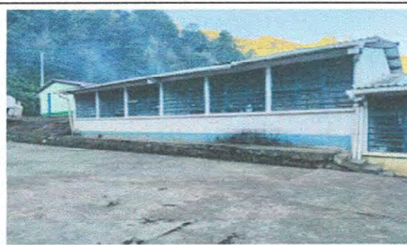
Foto 4: MODULO 1. Pintura en muro exteriores e interiores. Fabricación e instalacion de balcon de hierro en ventana.
