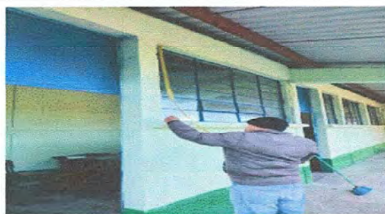
Foto 5: MODULO 2 Subministro e instalacion de balcon de hierro en ventana.
