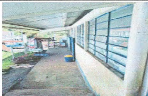
Foto 2: MODULO 1 Subministro e instalacion de balcon de hierro en ventana.
