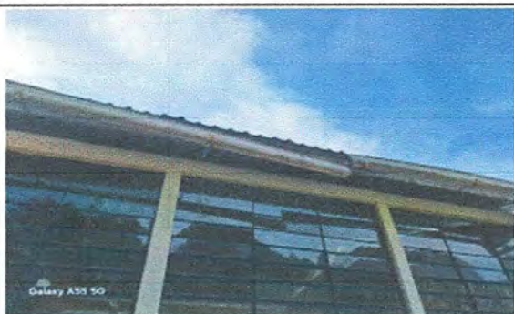
Foto 3: MODULO 1 Sustitucion de soporte o pescante de metal para canal.
