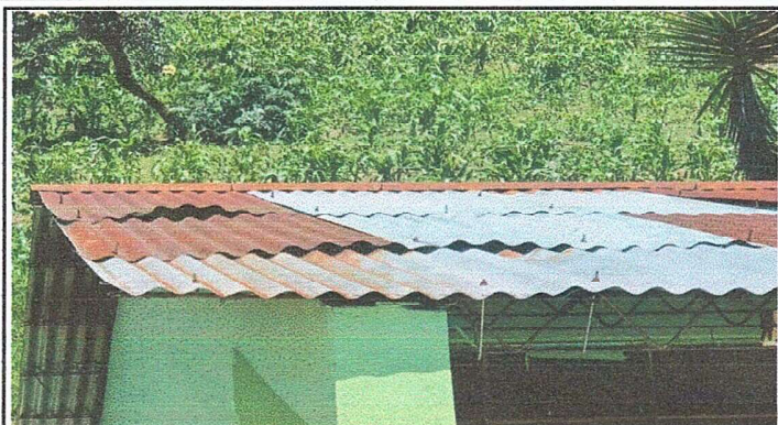
Foto1: Sustrucion de lamina por lamina troquelada aluzinc calibre 26 Modulo 1
