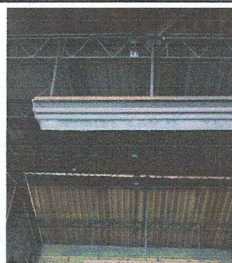
Foto 4: Sustrucion de estructura de soporte de metal por metal. Modulo 1
