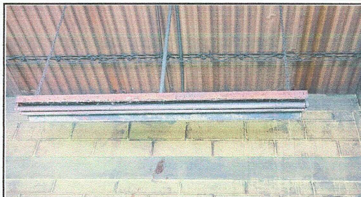
Foto 2: Sustrucion de lamparas 2x4. Modulo 1
