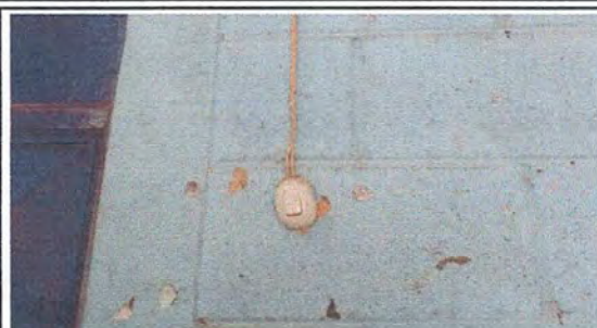
Foto 8: MODULO 2 Sustitución de interruptores
