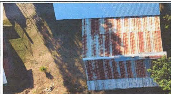
Foto 1: MODULO 2 Sustitución de lamina, por lamina troquelada Aluzinc calibre 26.
