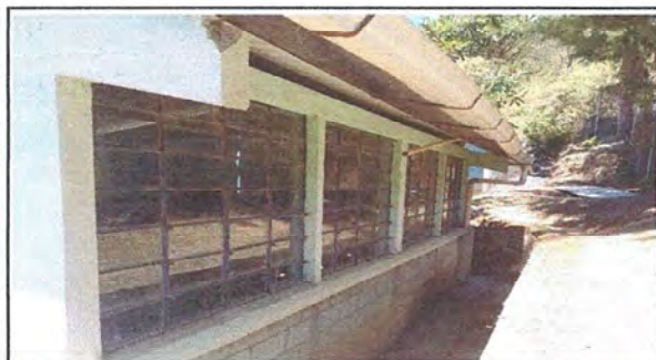
Foto 3: MODULO 2. Instalación de balcones de metal
