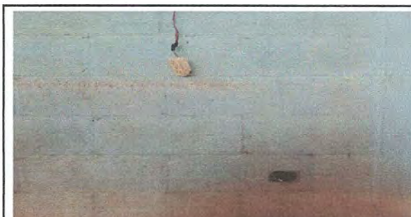
Foto 6: MODULO 2 Sustitución de ducto eléctrico + accesorio
