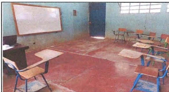
Foto 4: MODULO: 2 Sustitución de piso de torta de concreto.
