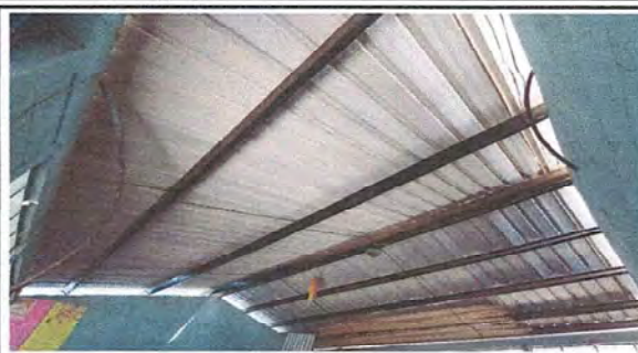
Foto 2: MODULO 2 Sustitución de estructura de soporte de metal, por metal
