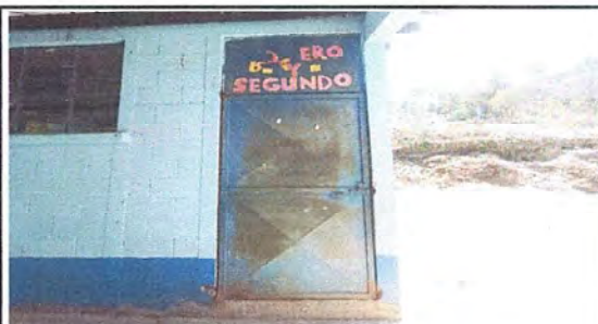
Foto 10: MODULO 2 Mantenimiento a estructura de puerta y pintado
