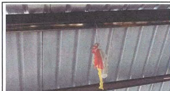
Foto 9: MODULO 2 Sustitución de plafoneras
