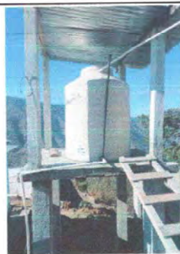
Foto 4: MODULO 2 Sustitución de deposito de agua 1700 lt.
