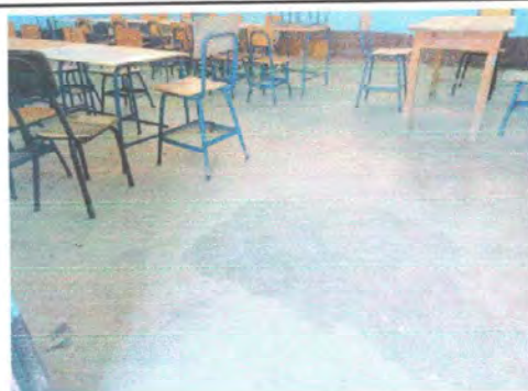
Foto 3: MODULO 2: Sustitución de piso de cemento liquido por piso cerámico.
