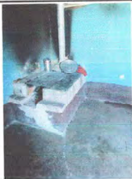
Foto 7: MODULO 2: Cocina: Sustitución de estufa rural (completa) incluye chimenea y plancha de metal.
