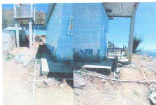
Foto 5: MODULO 2: Sustitución de tubería línea Principal de Red de agua potable
