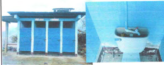
Foto 8: MODULO 3: Sustitución de accesorios inodoros (contra llave, tubo de abasto y tanque)
