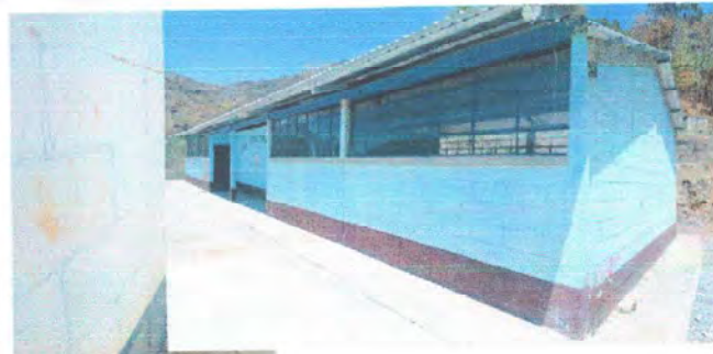
Foto 10: PINTURA GENERAL: Pintura en muros exteriores e interiores.
