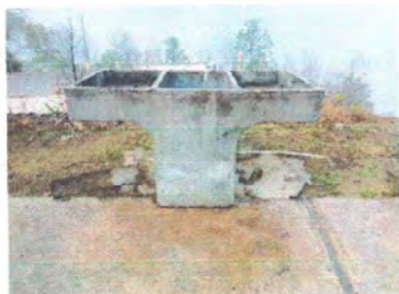
Foto 9: MODULO 3: Sustitución de pila de cemento de dos lavaderos
