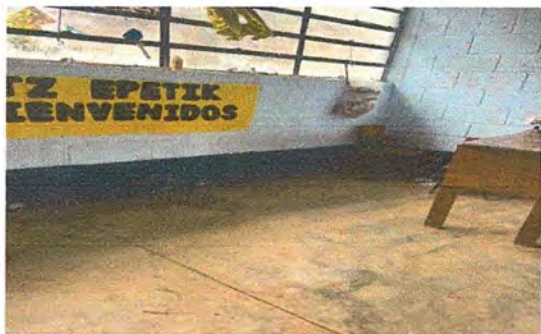
Foto 1 Modulo 1 Sustitución de piso de torta de concreto por piso ceramico
