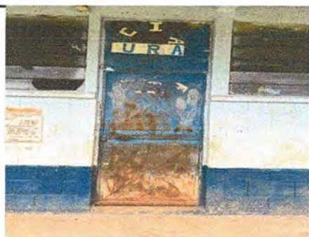
Foto 5 Modulo 1 cambio de Puertas
