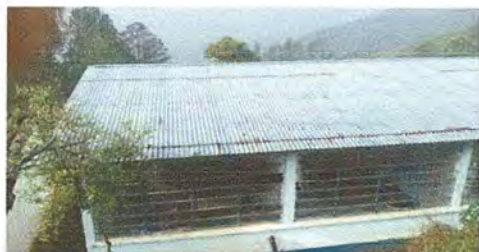
foto 9 Modulo 1 instalacion de lámina Troquelada
