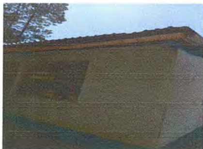
Foto 7 Modulo 1 Sustitucion de canal de pvc.
