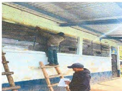
Foto 6 modulo 1 Sustitución de vidrios
