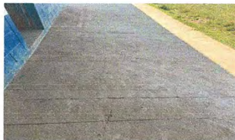
Foto 4 Modula 1 Reparación de piso de torta de concreto
