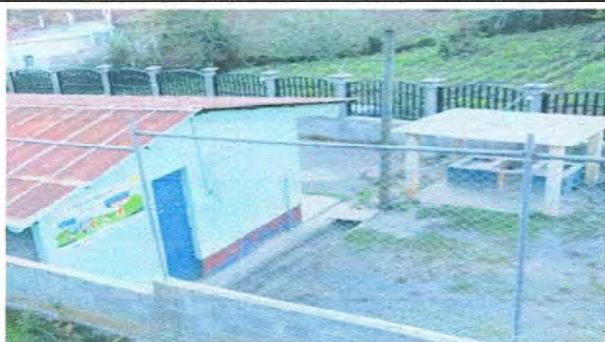
Foto 3 modulo 1 reparacion de bajada de agua pluvial
