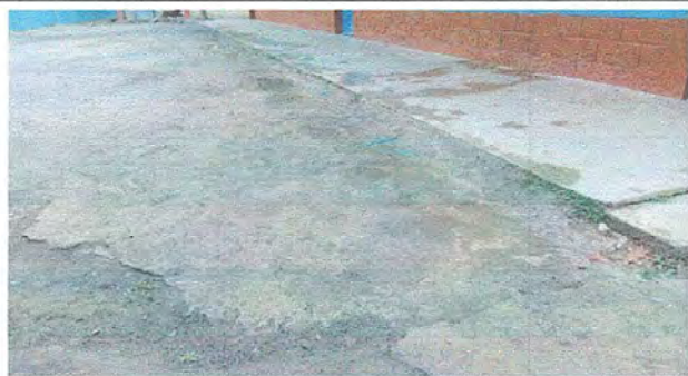
Foto 5 piso en el corredor
