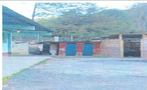
Foto 6 baños mantenimientos de puertas
