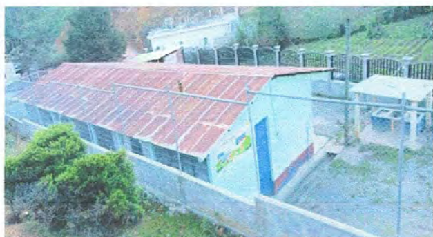
Foto 1, modulo 1 sustitucion de laminas
