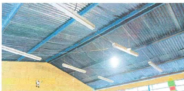
Foto 4 Modulo 1 Sustitución de cableado, plafonera, focos, interruptores y tomacorrientes
