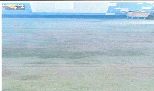
Foto 9: MÓDULO 4 Sustitución de piso de torta de concreto por piso cerámico.
