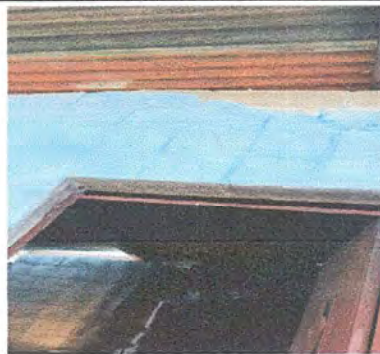
Foto 8: MÓDULO 3 Sustitución de lámina, por lámina troquelada aluzinc de 16 pies calibre 26, sustitución de estructura de soporte de madera, por metal.
