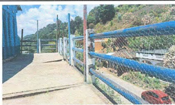
Foto 12: ÁREA EXTERIOR Reparación de tubo hg y malla Galvanizada.
