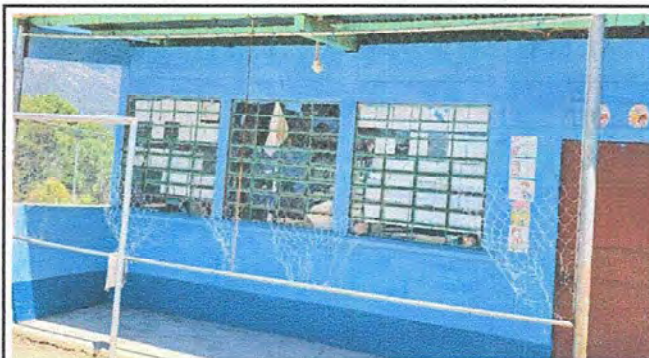
Foto 2: Módulo 1 Sustitución de tubo hg y malla Galvanizada.
