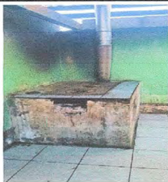
Foto 7: Módulo 2 Sustitución de plancha de metal de tres hornillas para estufa rural, pintura en paredes, marca fometex.
