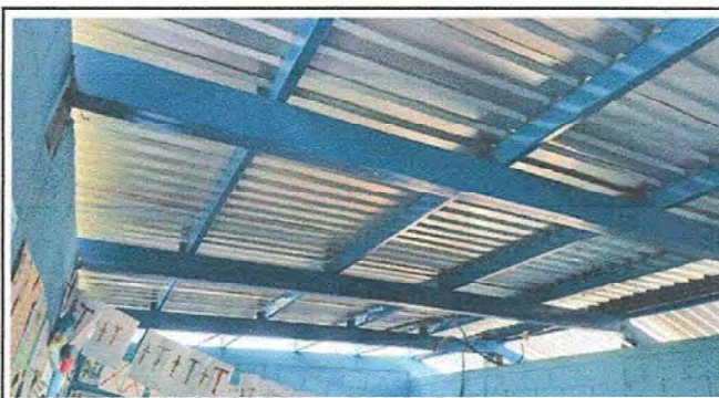
Foto 4: Módulo 2 Suministro de cable eléctrico (incluye ducto y accesorios, interruptores, tomacorrientes, unidad de luz)
