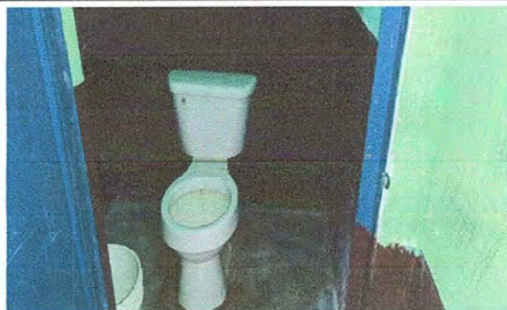
Foto 10: BAÑOS Sustitución de accesorios inodoro (contra llave, tubo de abasto y tanque).
