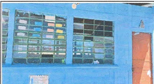
Foto 1: Módulo 1 Sustitución de vidrios.
