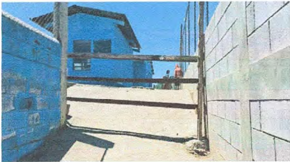
Foto 13: ÁREA EXTERIOR Sustitución de portón de barandas de madera por metal.
