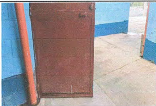
Foto 11: BAÑOS Sustitución de puertas de baños.
