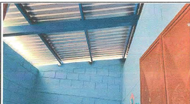
Foto 3: Módulo 2 Suministro de cable eléctrico (incluye ducto y accesorios, interruptores, tomacorrientes, unidad de luz)
