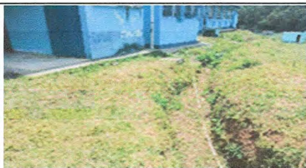
Foto 27: Sustitucion de tuberia linea principal
