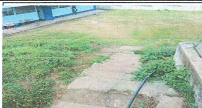
Foto 32: Sustitución de piso de concreto
