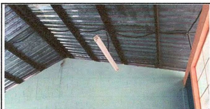
Foto 17: Modulo 4 Sustitucion de lamparas tipo LED
