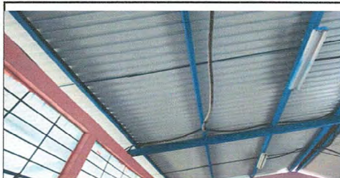
Foto 8: Modulo 2 Sustitucion de cableado electrico
