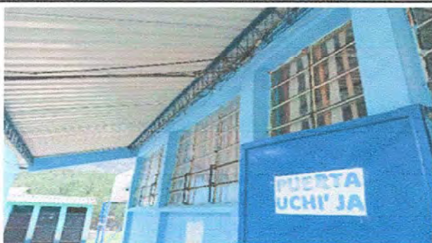
Foto1: Modulo 1 Instalacion unidad de luz
