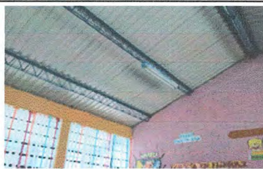
Foto 2: Modulo 1 Sustitucion de lampara tipo LED
