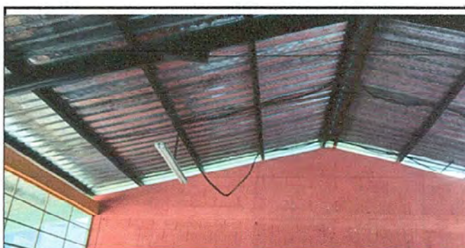
Foto 18: Modulo 4 Sustitucion cableado electrico
