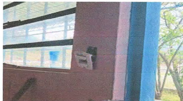
Foto 4: Modulo 1 Sustitucion interruptores dobles
