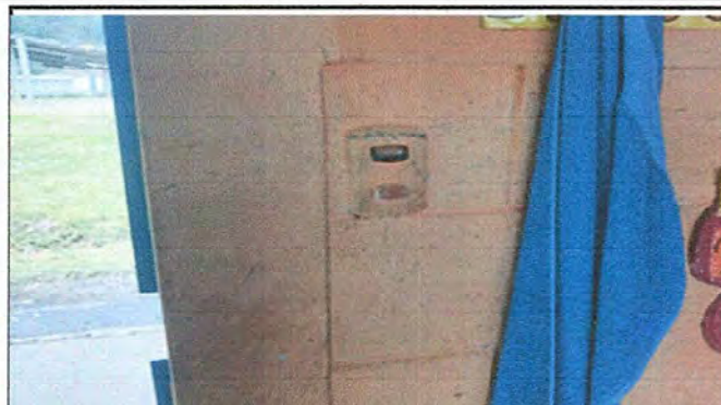
Foto 14: Modulo 3 Sustitucion de interruptores dobles
