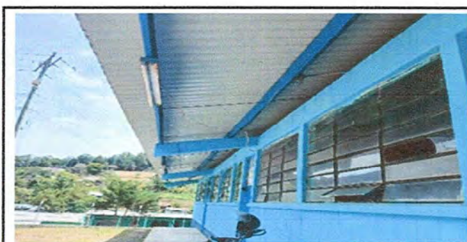
Foto 12: Modulo 3 Sustitucion de lamparas tipo LED
