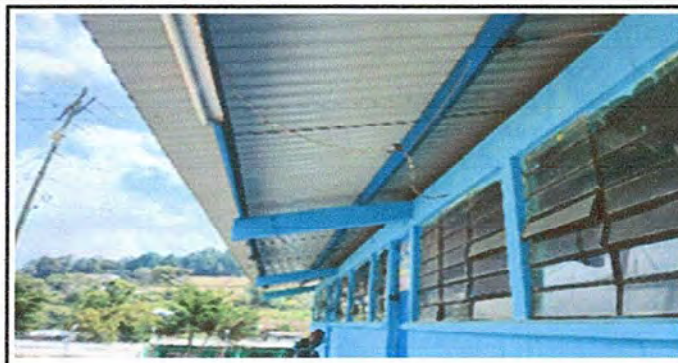
Foto 13: Modulo 3 Sustitucion de cableado electrico
