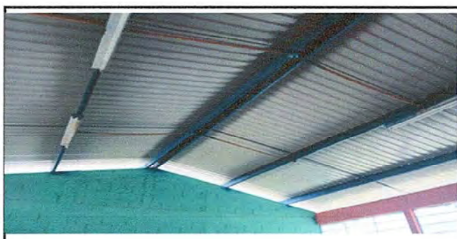
Foto 11: Modulo 3 Instalacion unidades de luz
