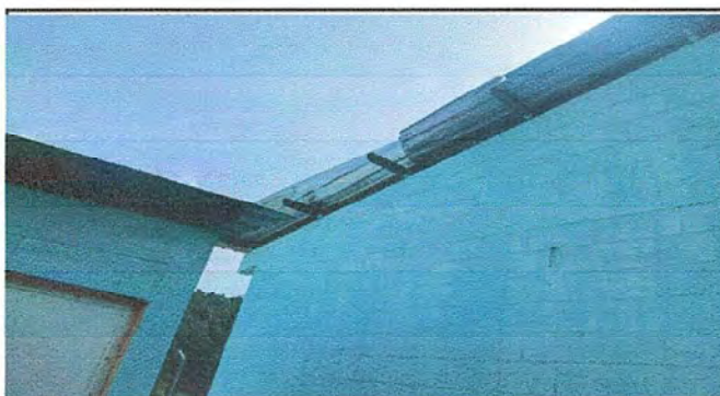
Foto 21: Modulo 4 Sustitucion de lamina, lamina troquelada aluzinc calibre 26
