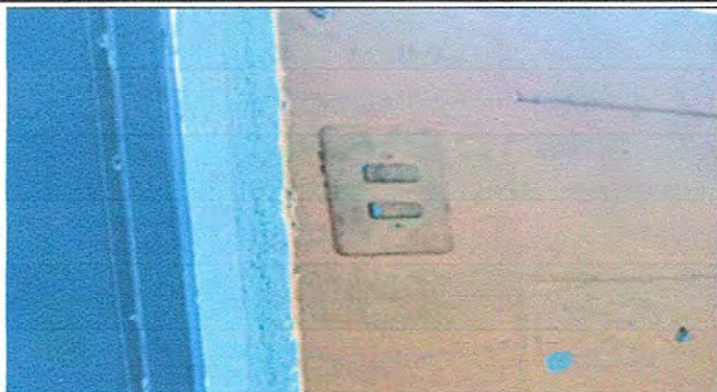
Foto 19: Modulo 4 Sustitucion interruptores dobles
