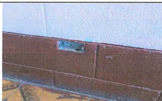
Foto 5: Modulo 1 Sustitucion tomacorriente dobles
