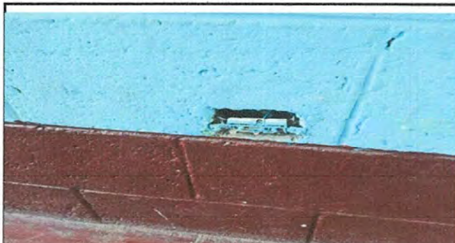
Foto 10: Modulo 2 Sustitucion tomacorrientes dobles
