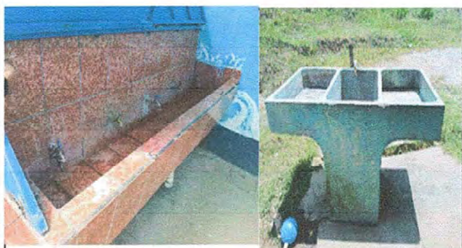
Foto 29: Sustitucion de llave de chorro
