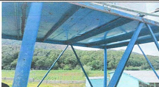
Foto 31: Reparación base para soporte de agua
