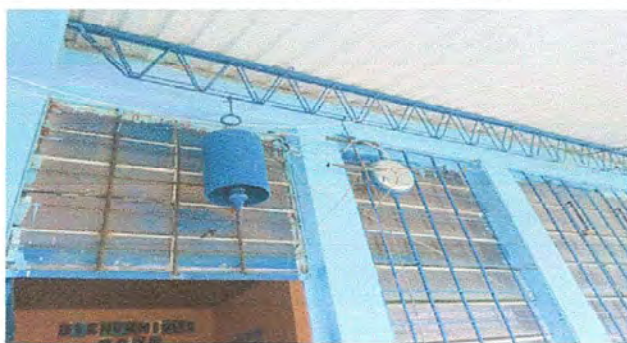
Foto 3: Modulo 1 Sustitucion cableado electrico
