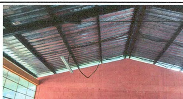
Foto 16: Modulo 4 Instalacion unidades de luz
