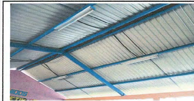
Foto 7: Modulo 2 Sustitucion de la lamparas tipo LED
