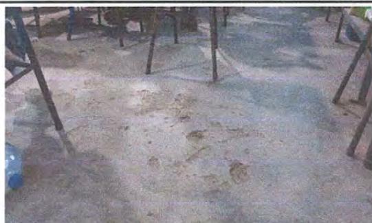
Foto 5: MODULO 1 Sustrución de piso de torta de concreto por piso cerámico.
