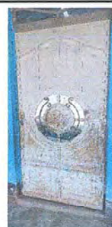
Foto 6: MODULO 1 Mantenimiento de estructura de puerta ( lijado, cambio de tubo, cepillado, cambio de pintura)
