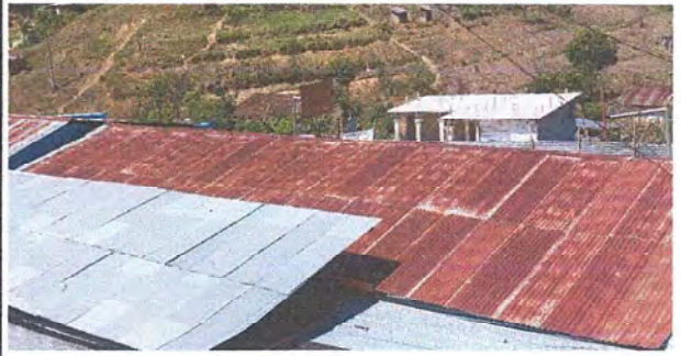
Foto 4: MODULO 1 Instalación de láminas troqueladas aluzinc calibre 26
