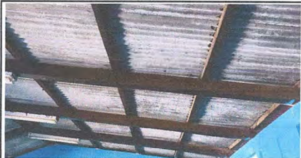
Foto 2: MODULO 1 Sustitucion de estructura de soporte de madera, por metal
