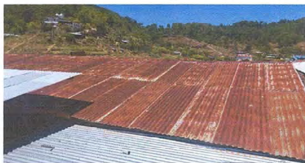
Foto 3: MODULO 1 Desinstalación de láminas existentes.
