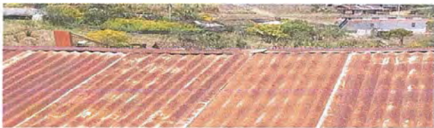
Foto 1: MODULO 1 Sustrución de capote de lamina para lámina troquelada
