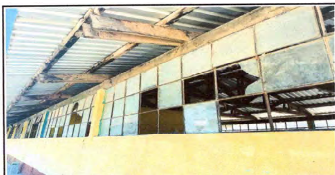
Foto 5: MODULO 3. VENTANAS. Sustitución de vidrios
