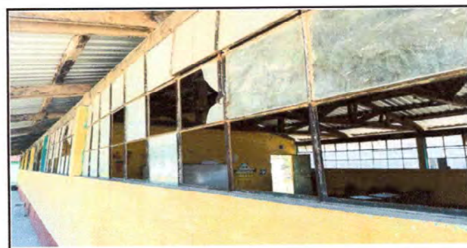
Foto 6: MODULO 3. VENTANAS. Sustitución de vidrios
