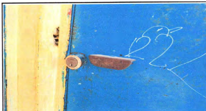
Foto 4: MODULO 2. PUERTAS DE METAL. Sustitución de chapa de cuatro aulas
