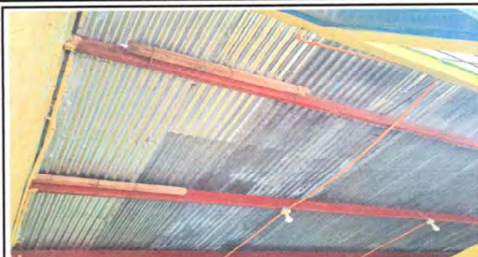
Foto 2: MODULO 1. CUBIERTA DE LÁMINA. Sustitución de lámina, por lámina troquelada alucinc calibre 26 para tres aulas.
