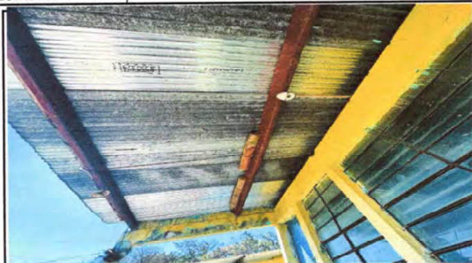
Foto 1: MODULO 1. CUBIERTA DE LÁMINA. Sustitución de lámina, por lámina troquelada alucinc calibre 26 para tres aulas.
