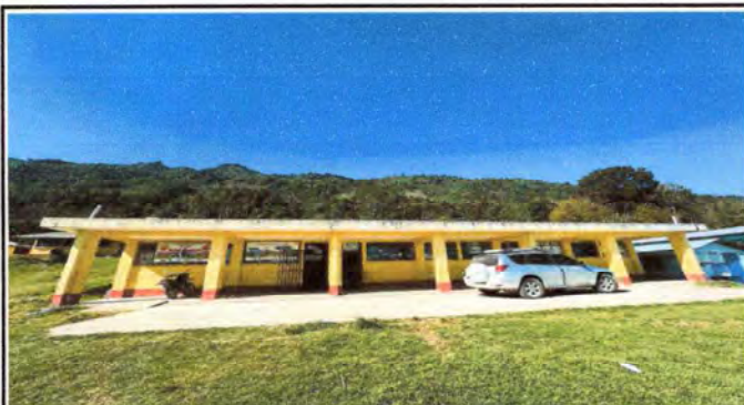
Foto 7: MODULO 4. PINTURA EN MUROS EXTERIORES E INTERIORES. Pintura en muros exteriores e interiores para 17 aulas.
