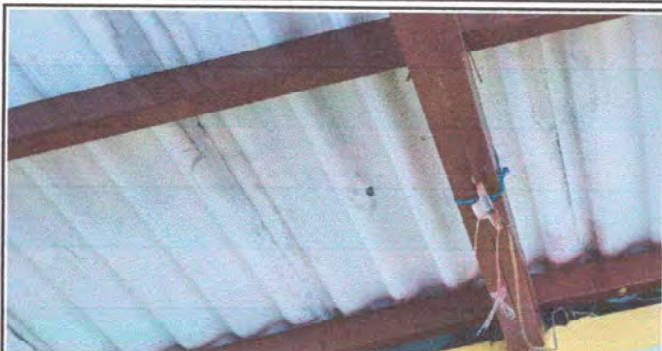
Foto7: Modulo 1: Sustitucion de cableado, plafoneras, flipones, focos ahorradores,
