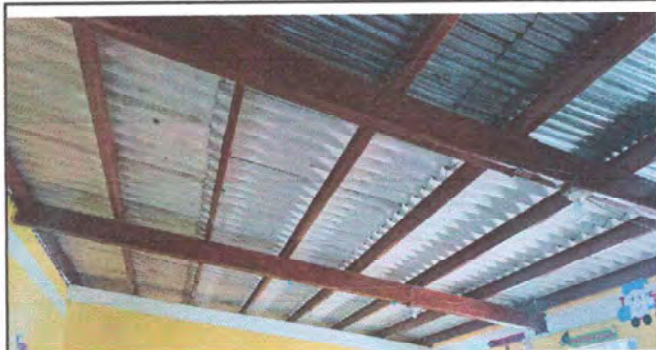
Foto 3: Modulo 1: Mantenimiento a estructura de soporte metal
