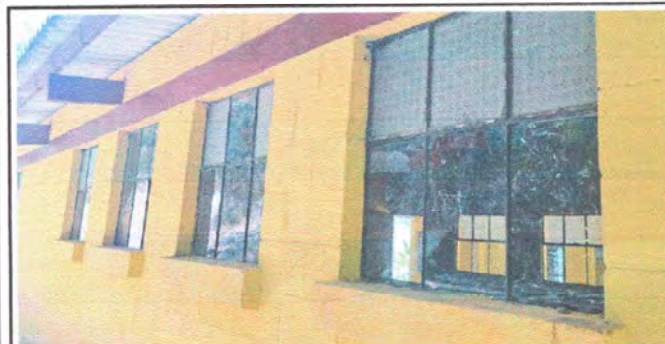
Foto 5: Modulo 1: sustitucion de vidrios
