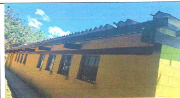
Foto 4: Modulo 1: Suministro e instalación de balcones de metal
