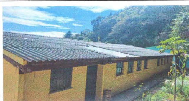
Foto 2: Modulo 1: Sustitución de lamina por lamina troquelada aluzinc calibre 26
