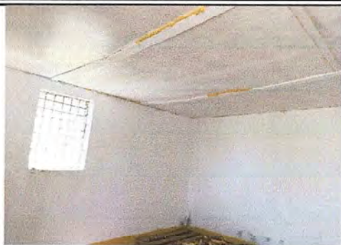
Foto13: Modulo 2 Sustitución de focos ahorradores, sustitución de plafoneras, sustitución de interruptores dobles, sustitucion de tomacorrientes dobles, sustitución de flípones, reparacion de cableado
