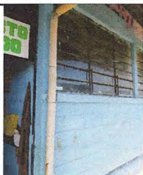
Foto 3: Modulo 1 Sustitución de bajada de agua de metal por tubo PVC 3"
