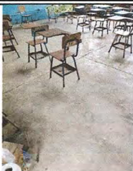
Foto 1: Modulo 1 Sustitución de piso torta de cemento por piso ceramico
