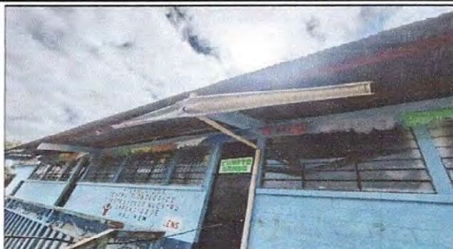
Foto 2: Modulo 1 Sustitución de canal de pvc
