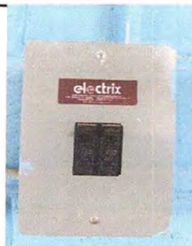
Foto 10: Modulo 1 Sustitución de tableros de flípones
