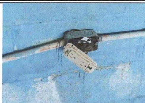
Foto 8: Modulo 1 Sustitución de tomacorrientes dobles
