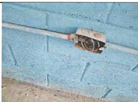
Foto 11: Modulo 1 Reparación de cableado eléctrico
