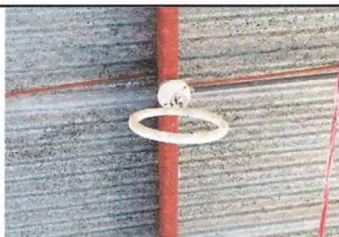
Foto 5: Modulo 1 Sustitucion de focos ahorradores
