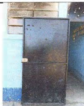
Foto 4: Modulo 1 Mantenimiento a estructura de puerta (lijado, cambio de tubo, cepillado, sujeciones, aplicación de pintura)
