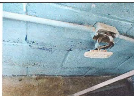
Foto 12: Modulo 1 Sustitución de ducto eléctrico + accesorios
