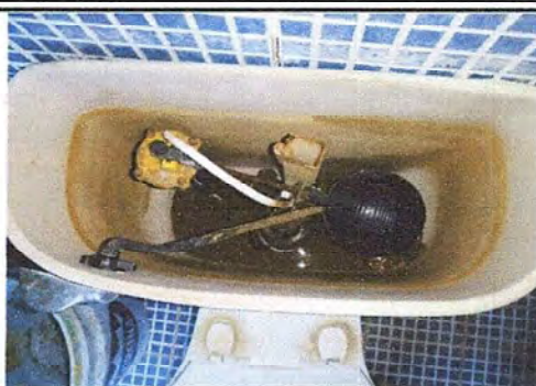
Foto 14: Modulo 3 Sustitución de accesorios inodoro (contra llave, tubo de abasto y tanque)
