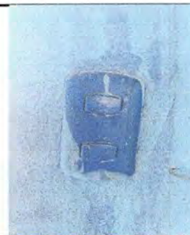
Foto 6: Modulo 1 Sustitución de interruptores simples
