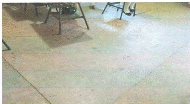
Foto 3: MODULO 1. Desinstalación (de piso existente).Sustitución de piso de cemento por piso ceramico
