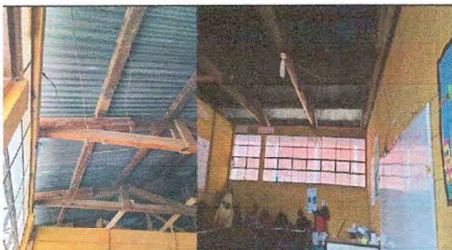
Foto 4: Modulo 1: Instalación de unidad de luz.
