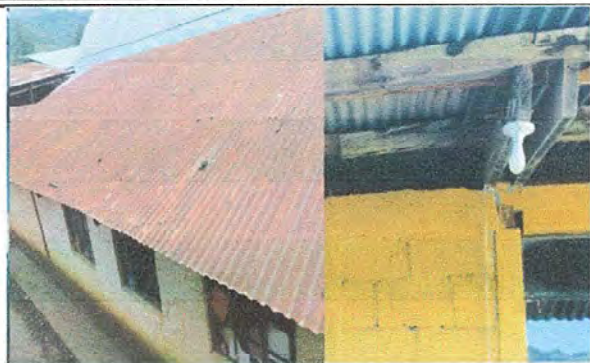
Foto1: MODULO 1. Desinstalación de laminas existente incluye andamio. Sustitución de laminas por lámina troqueladas Alucinc calibre 26. Sustitución de capotes de láminas troquelada alucinc calibre 26. Pintura
