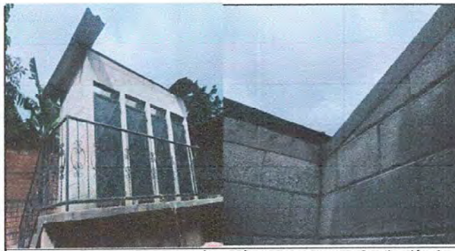
Foto 6: Sanitarios. Desinstalación de láminas existentes. Sustitución de láminas por láminas troqueladas alucinc calibre 26.
