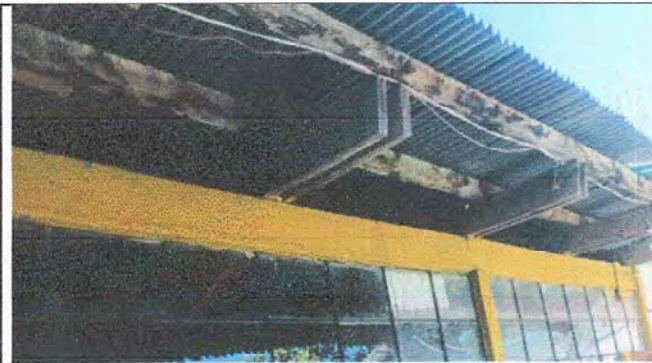
Foto 2: MODULO 1. Instalación de soporte de metal (techo). Instalación de unidad de luz.
