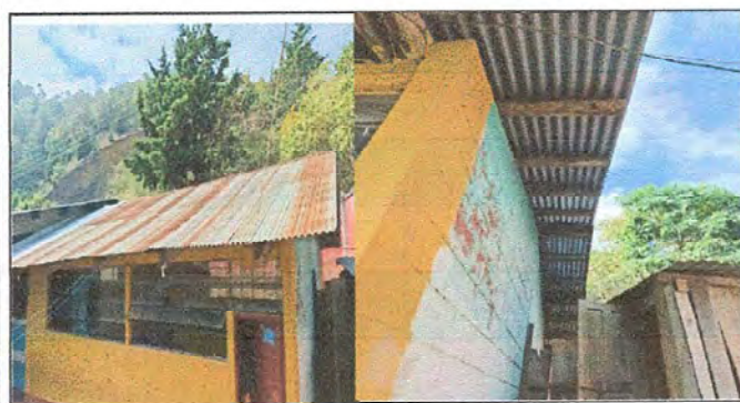
Foto 5: Modulo 1 Pintura en muros exteriores e interiores
