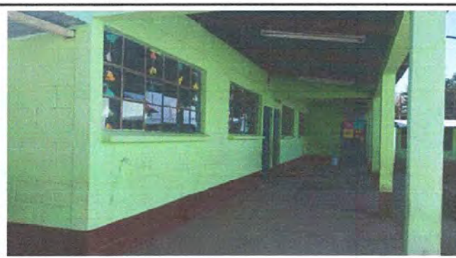
Foto 4: MÓDULO 2: Pintura en muros, sustitución de plafoneras, sustitución de focos ahorradores y reparación de cableado eléctrico.
