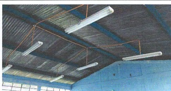
Foto 8: MÓDULO 4: Sustitución de plafoneras, reparación de cableado eléctrico y sustitución de focos ahorradores.
