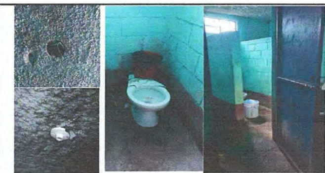
Foto 10: SANITARIOS: Sustitución de plafoneras, sustitución de focos ahorradores, sustitución de inodoro, instalación de inodoro y sustitución de puertas en servicios sanitarios.
