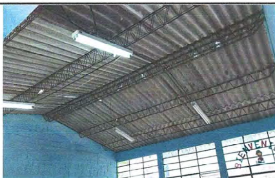
Foto 3: MÓDULO 1: Sustitución de plafoneras, reparación de cableado eléctrico y sustitución de focos ahorradores.
