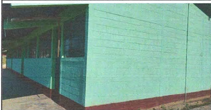
Foto 7: MÓDULO 4: Pintura en muros.
