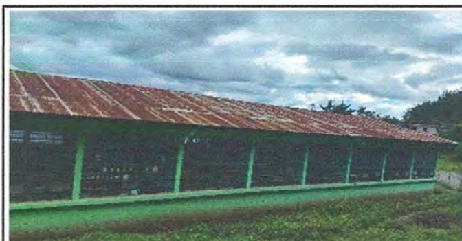
Foto 9: MÓDULO 4: Sustitución de vidrios.
