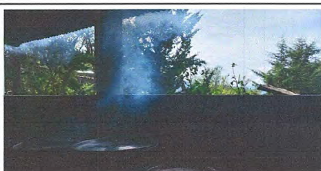
Foto 12: COCINA: Sustitución de balcón de metal.
