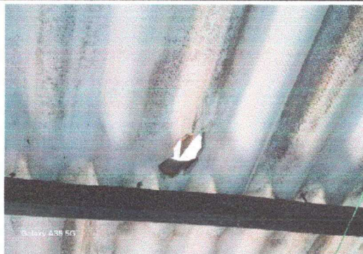
Foto 1. Módulo 1: Sustitución de lámina, por lámina troquelada aluzinc calibre 26
