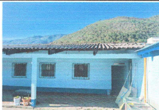
Foto 4. Módulo 1: Instalación de estructura portante de metal.
