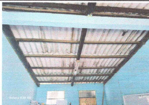
Foto 2. Módulo No. 1. Sustitución de estructura de soporte de madera, por metal
