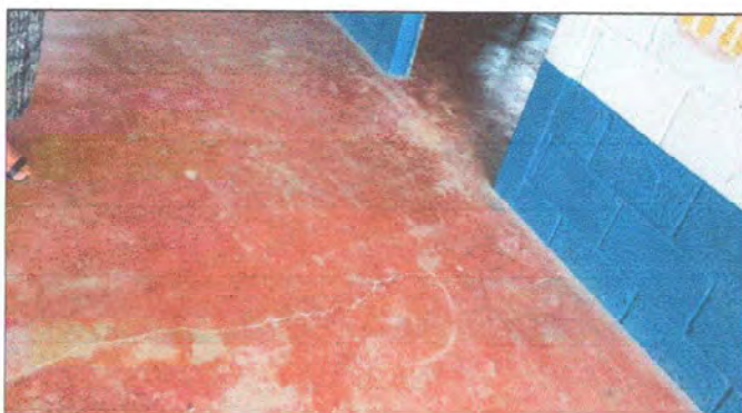
Foto 3. Módulo 1: Aula No. 2, sustrucción de piso de cemento liquido por piso cerámico.
