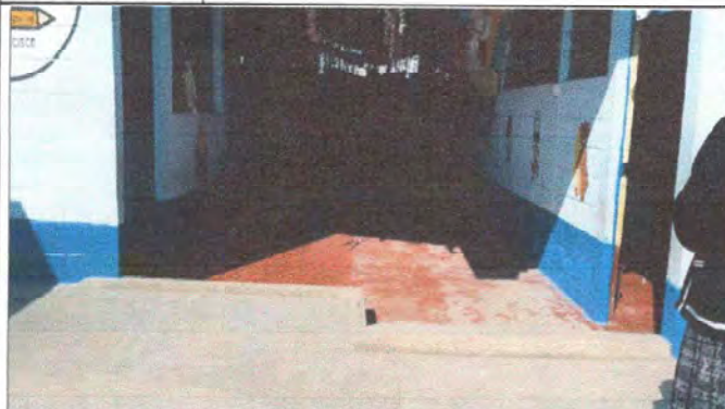
Foto 1. Módulo 1: Sustrucción de piso de cemento liquido por piso cerámico antideslizante. Corredor del establecimiento.
