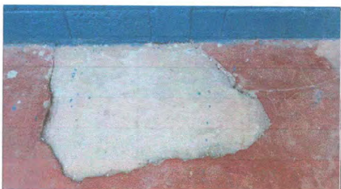
Foto 4. Módulo: Aula No 3, sustrucción de piso de cemento liquido por piso cerámico.
