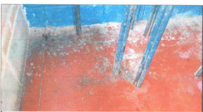
Foto 6. Módulo: Bodega, sustrucción de piso cemento liquido por piso cerámico
