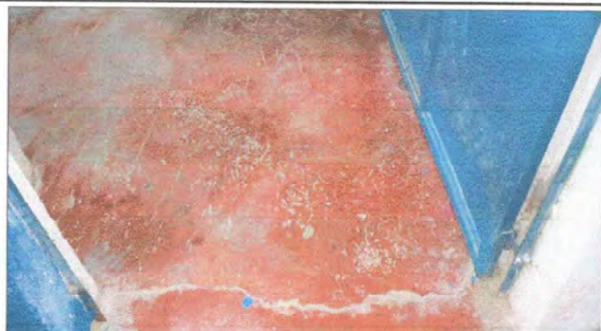
Foto 2. Módulo 1: Aula No. 1, sustrucción de piso de cemento liquido por piso cerámico.
