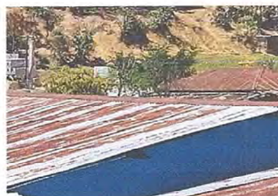
Foto 4 MODULO 1 Instalación de lámina troquelada aluzunc
