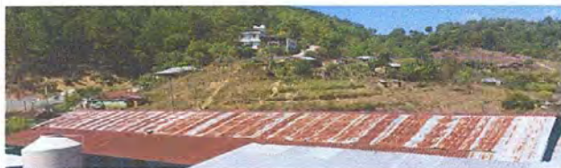
Foto 9: Modelo 1 Sustitución de lámina, por lamina troquelada aluzunc calibre 26
