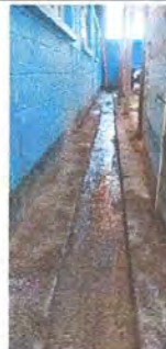
Foto 8: Modelo 1 Reparación de cuneta de concreto.
