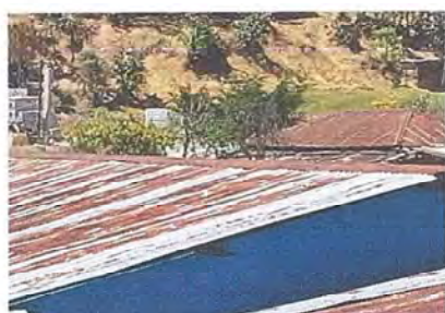
Foto 3: MODULO 1 Desinstalación de láminas existente.
