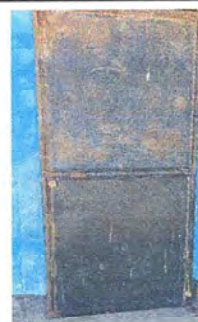
Foto 6: MODULO 1 Mantenimiento de estructura de puertas, lijado, cepillado y aplicación de pintura
