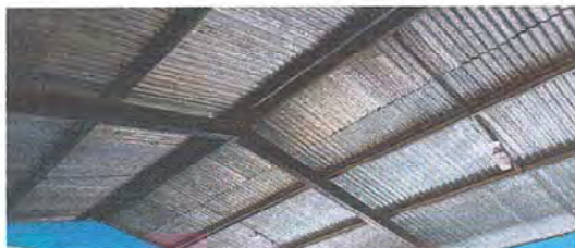
Foto 1: MODULO 1 Mantenimiento de estructuras metalica, lijado, cepillado y aplicación de pintura.
