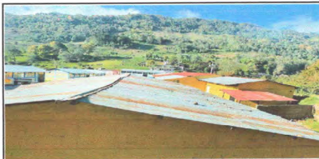
Foto 4: MODULO 2. Sustitucion de laminas por laminas traqueladas
