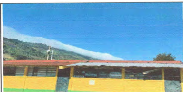
Foto 9: MODULO 4. Sustitución de láminas por laminas troqueladas
