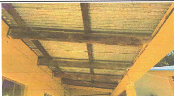
Foto 5: MODULO 2. Sustitución de madera por estructura de metal
