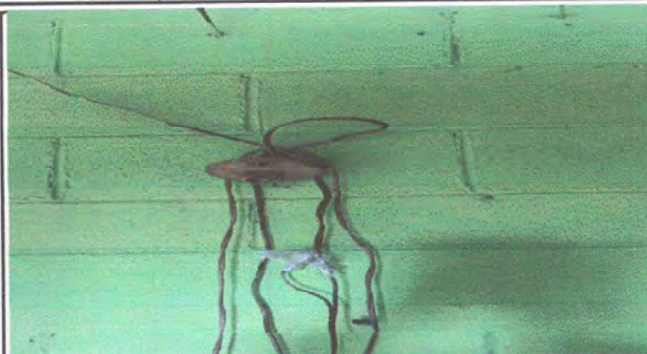
Foto 8: MODULO 3. Sustitución de foco
