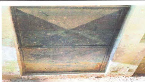
Foto 2: MODULO 1. Mantenimiento de puerta de metal
