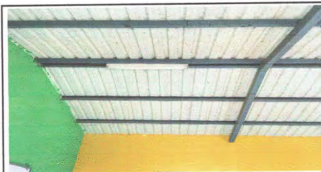
Foto 12: MODULO 5. Sustitución de focos
