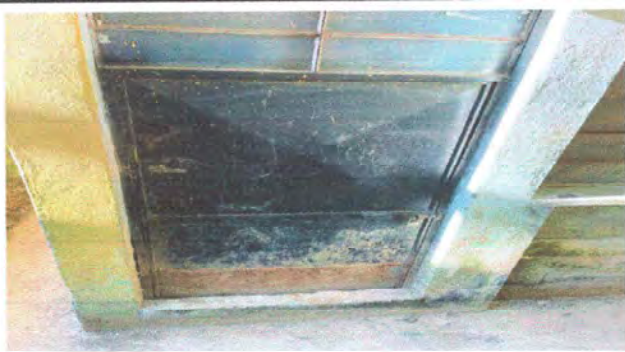
Foto 3: MODULO 1. Mantenimiento de puerta de metal
