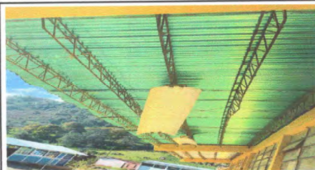
Foto 10: MODULO 4. Sustitución de joist por estructura de metal
