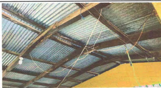
Foto 6: MODULO 2. Sustitucion de foco, cable, plafoneros, apagador y tomacorriente
