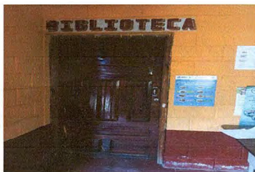
Foto 3:MODULO 1 Sustitución de puerta
