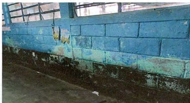
Foto 5: Modulo II Pintado de pared interior y exterior.
