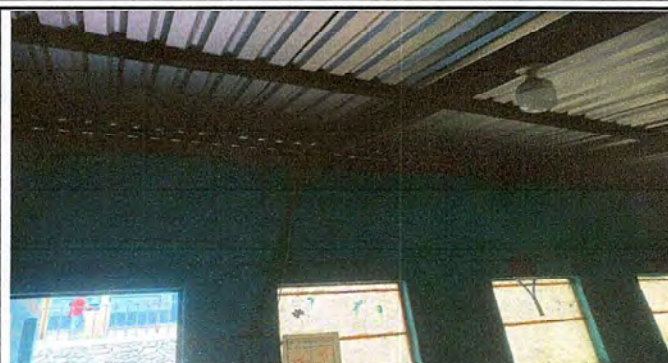
Foto 2: MODULO 1 cambio de instalación eléctrica
