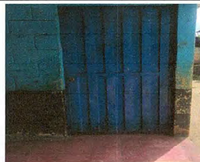
Foto 4: MODULO 1 Mantenimiento de estructura de puerta (lijado, cambio de tubo, cepillado, aplicación de pintura
