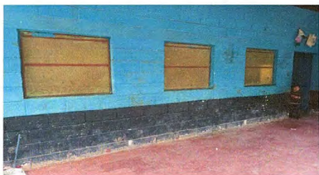
Foto1: MODULO 1 sustitución de estructuras de metal de ventanas
