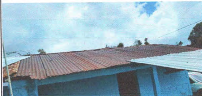
Foto 4: MODULO 1: Sustitución de lámina, por lámina troquelada aluzinc calibre 26
