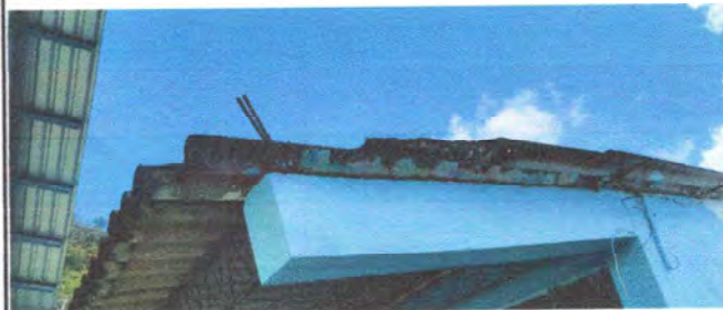
Foto 2: MODULO 1: Sustitución de lámina, por lámina troquelada aluzinc calibre 26
