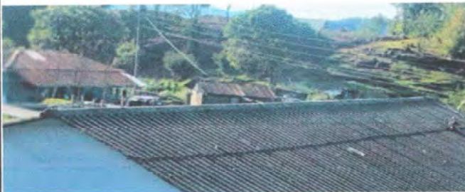
Foto 7: MODULO 1: Sustitución de capote de lámina para lámina troquelada
