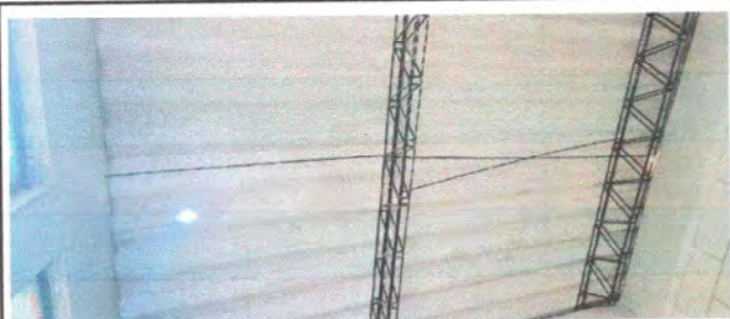
Foto 3: MODULO 1: Sustitución de lámina, por lámina troquelada aluzinc calibre 26
