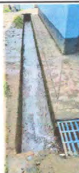
Foto 11: MODULO 1: Suministro e Instalación de rejilla
