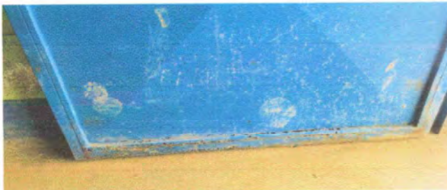
Foto 9: MODULO 1: Sustitución e instalación de puerta de metal
