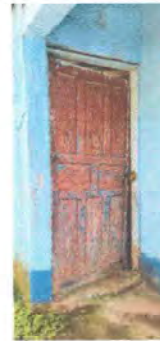
Foto 8: MODULO 1: Sustitución e instalación de puerta de metal
