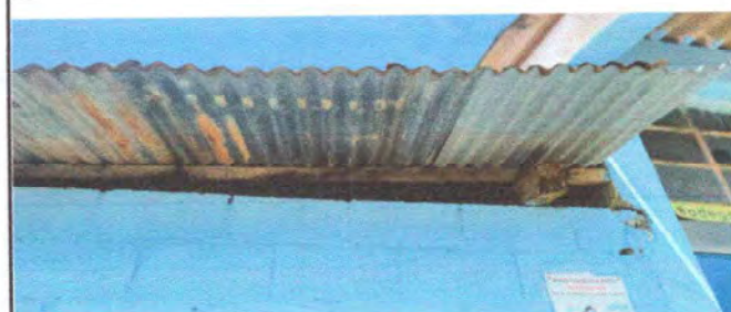
Foto 6: MODULO 1: Sustitución de estructura de soporte de madera, por metal
