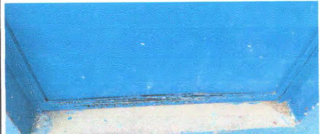
Foto 10: MODULO 1: Sustitución e instalación de puerta de metal
