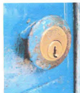
Foto 12: MODULO 1: Sustitución de chapa
