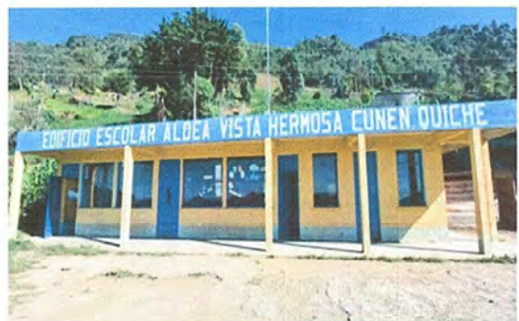
Foto 4: Modulo 1: Pintura en muros exteriores e interiores
