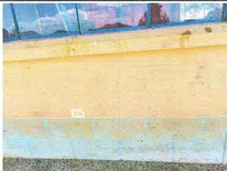
Foto 7: Modulo 1: Sustitución de tomacorrientes
