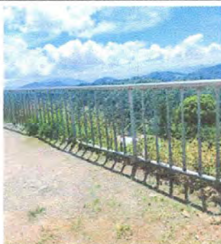
Foto 9: Modulo 1: sustitucion de baranda de metal
