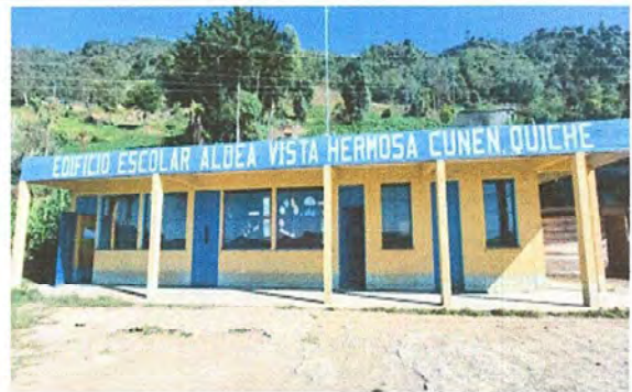
Foto 2: Modulo 1, Fabricacion e instalacion de balcon de hierro en ventana
