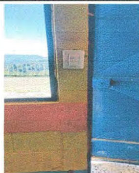
Foto 8: Modulo 1: Sustitución de interruptores
