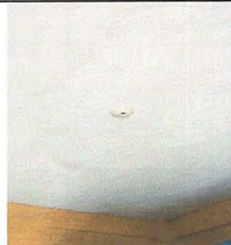
Foto 6: Modulo 1: Sustitucion de focos ahorradores
