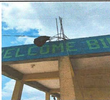
Foto 5: Modulo 1: Reparación de cableado eléctrico
