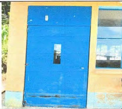
Foto1: Modulo 1, Sustitucion de puerta de metal
