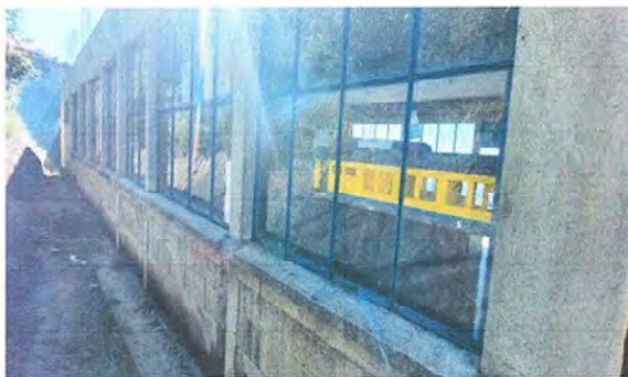
Foto 3: Modulo 1, Fabricacio de balcones de hierro en ventana
