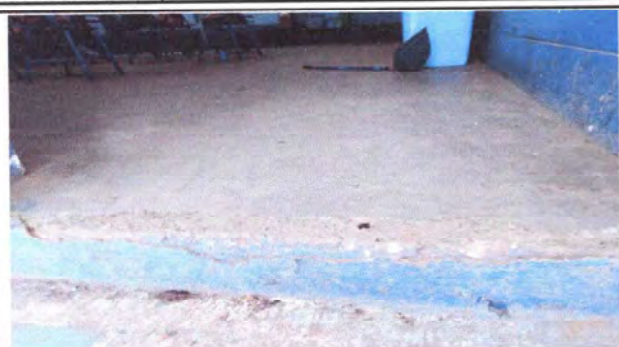
Foto 1: Aulas No. 1 al 3. Sustitución de piso por piso cerámico anti deslizante.
