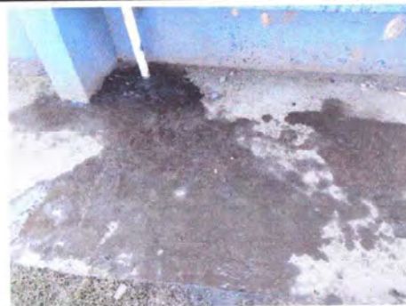
Foto 8: Reparación de sistema de aguas negras en baños de modulos de baños
