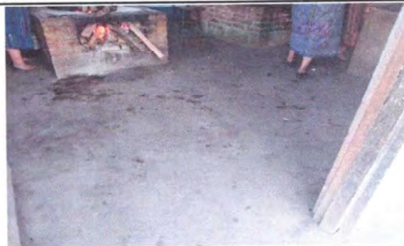
Foto 2: Cocina sustitución de piso modulo de cocina, por ceramica antideslizante.
