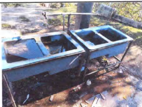
Foto 9: Sustitución de sistema de aguas negras en lavamanos
