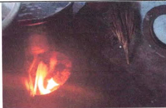
Foto 4: Sustitución de 3 planchas de la cocina de tres polletones de leña.
