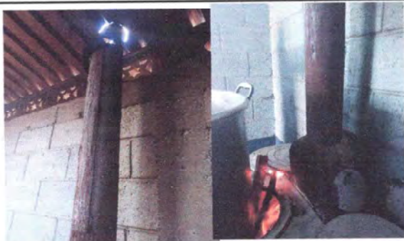
Foto 3: Módulo cocina. Sustitución de chimeneas con arreglo de base y sobre la lamina para la filtración de agua
