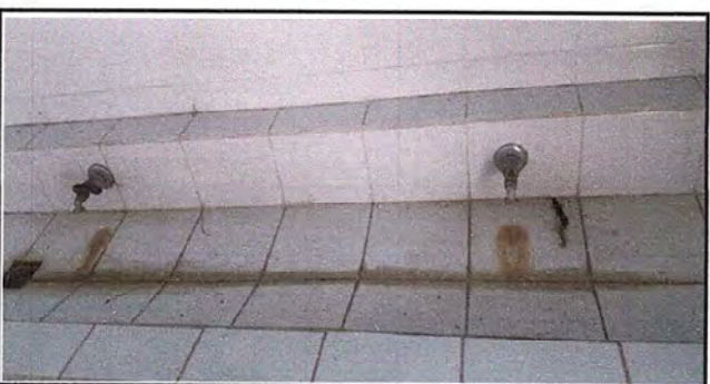
Foto 11: Modulo 6: Sustitución de glifos
