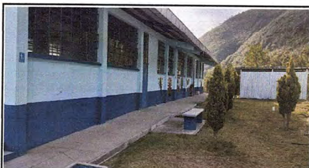
Foto 9: MODULO 5: Sustitución de chapa
