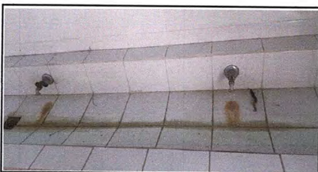
Foto 11: Modulo 6: Sustitución de glifos
