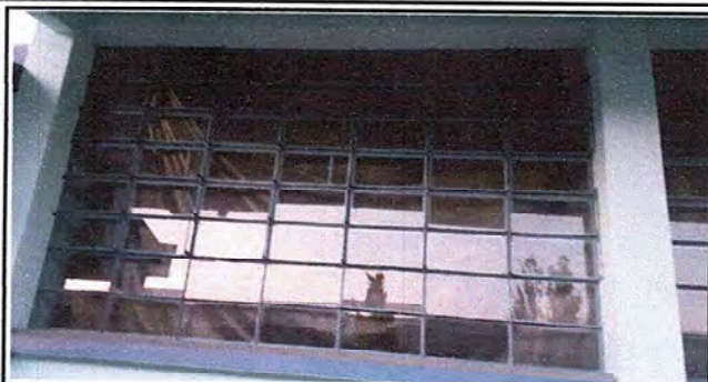
Foto 7: MODULO 4: Suministro e instalación de balcones de metal
