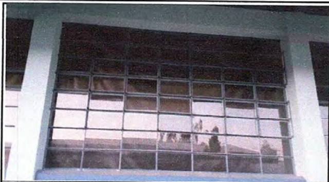
Foto 1: MODULO 1: Suministro e instalación de balcones de metal
