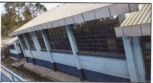
Foto 5: MODULO 3: Suministro e instalación de balcones de metal
