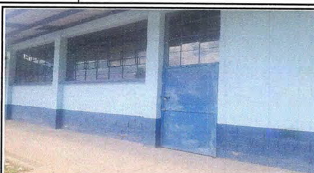
Foto 8: MODULO 4: Sustitución de chapa
