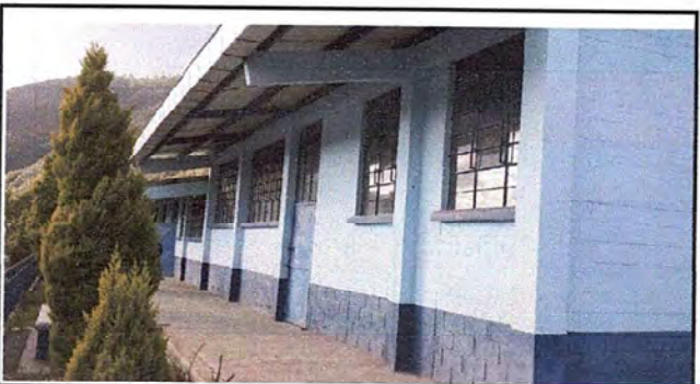
Foto 3: MODULO 2: Suministro e instalación de balcones de metal
