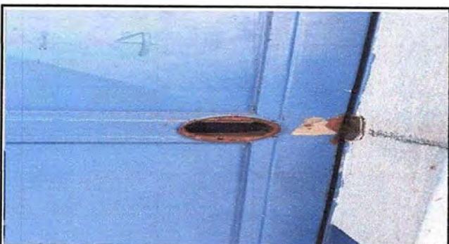
Foto 9: MODULO 5: Sustitución de chapa
