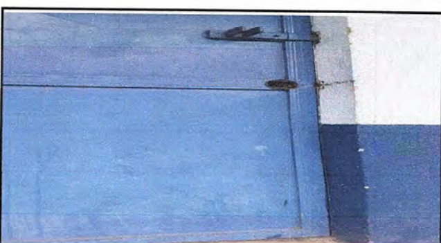
Foto 4: MODULO 2: Sustitución de chapas
