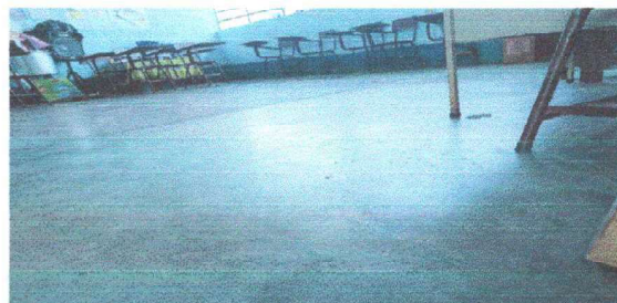
Foto 2: Modulo 1 Sustitución de piso de cemento liquido, por piso cerámico
