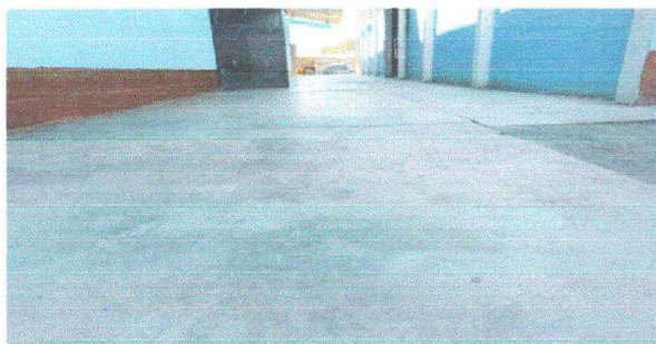
Foto 3: Modulo 1 Sustitución de piso de cemento liquido, por piso cerámico
