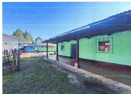
Foto 14: PINTURA GENERAL : Aplicación de pintura en muros exteriores e interiores.
