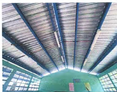
Foto 4: MODULO 1: Sustitución de lamparas de 2 x 40 por plafoneras.
