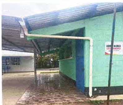
Foto 3: MODULO 1: Reparación de bajadas de agua
