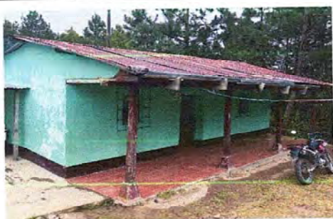
Foto 11: MÓDULO 3: Sustitución de canal de metal por canal de PVC 3". Suministro e instalación de bajada de agua pluvial de tubo PVC 3".
