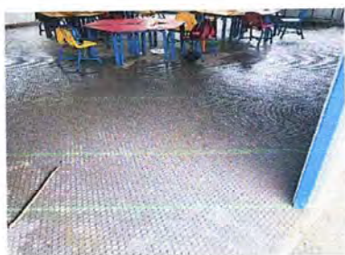
Foto 9: Modulo 2: Sustitución de piso plástico por piso cerámico.
