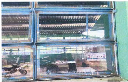
Foto 2: MODULO 1: Sustitución de vidrios. Sumistro, fabricación e instalación de balcón de hierro de ventana. Mantenimiento a estructura de metal de ventana
