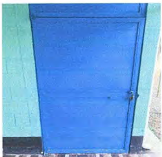
Foto 1: MODULO 1: Mantenimiento a estructura de puerta (cambio de tubo y sujeciones)
