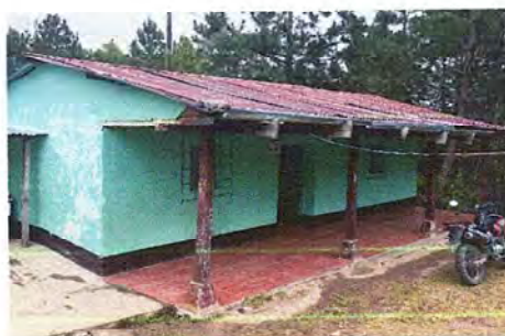
Foto 10: Modulo 3: Sustitución de lámina por lámina troquelada calibre 26. Sustitución de capote de lámina por lamina troquelada.
