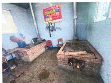
Foto 8: COCINA: Instalación de azulejo en estufa rural.
