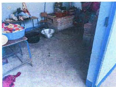
Foto7: COCINA: Sustitución de torta de concreto por piso cerámico.
