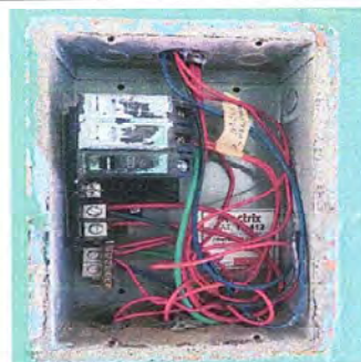
Foto 6: MODULO 1: Sustitución de flipones
