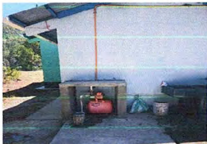
Foto 13: CISTERNA DE AGUA: Reparación de bomba de agua. Suministro, fabricación e instalación de balcón de hierro.
