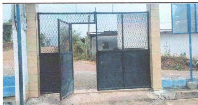
Foto 11: MURO PERIMETRAL. Reparación de portón.
