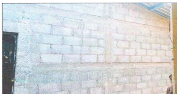
Foto 5: MODULO 1 Repello de muro
