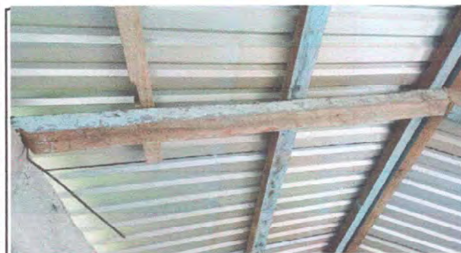
Foto 9: MODULO 1 Sustitución de reglas de madera por costaneras de metal
