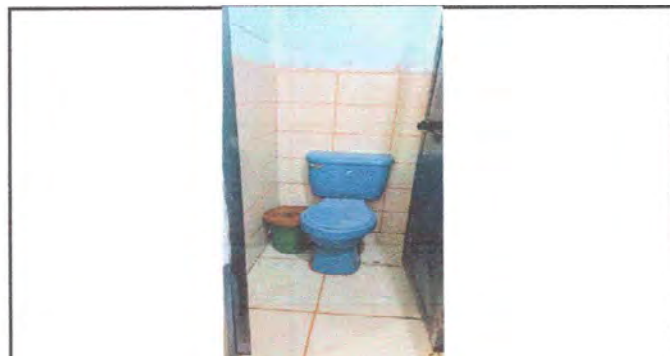
Foto 12: MODULO 1 Sustitución inodoro
