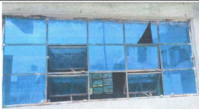
Foto 1: MODULO 1 Fabricación e instalación de ventanas de metal
