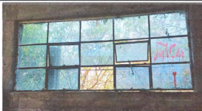
Foto 2: MODULO 1 Fabricación e instalación de ventanas de metal
