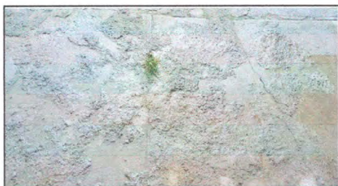
Foto 10: MODULO 1 Sustitución de piso de torta de concreto
