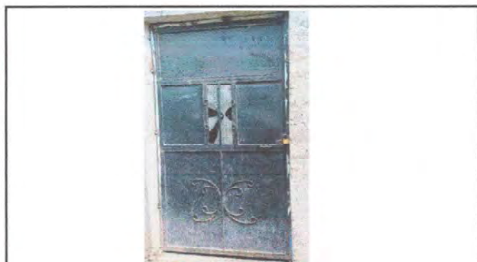
Foto 3: MODULO 1 Sustitución de estructura de metal de puerta
