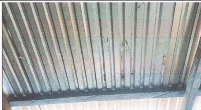
Foto 8: MODULO 1 Sustitución e instalación de estructura de lamina calibre 26
