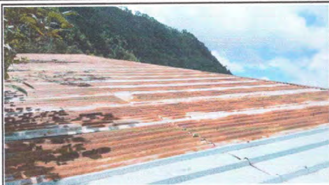
Foto 1: Módulo 1 Sustitución de Láminas por lámina troquelada aluzin calibre 26
