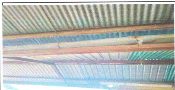
Foto 5: Módulo 1 Sustitución de Canal de metal
