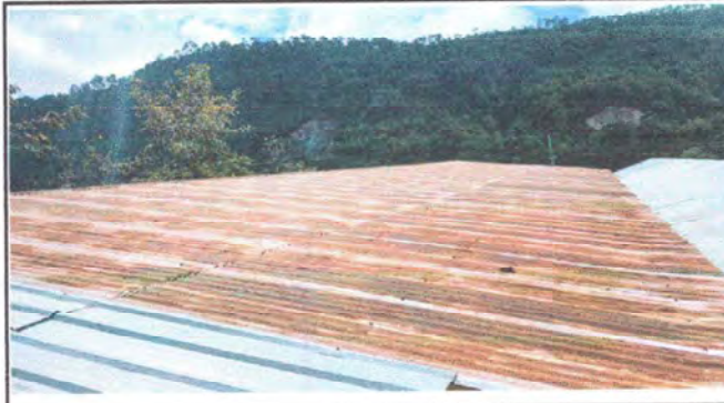
Foto 2: Módulo 1 Sustitución de Láminas por lámina troquelada aluzin calibre 26
