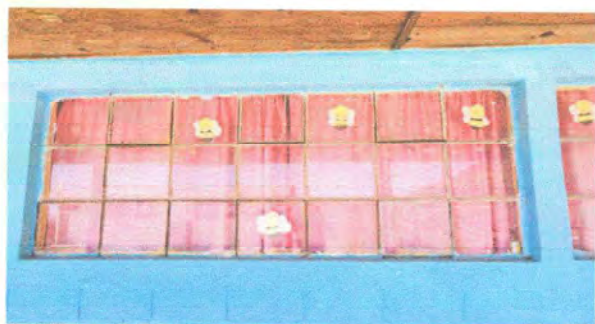
Foto 1: MODULO 1 Estructura de metal de ventana
