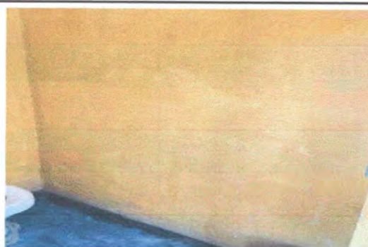
Foto 6: MODULO 3 Sustitución de Azulejo
