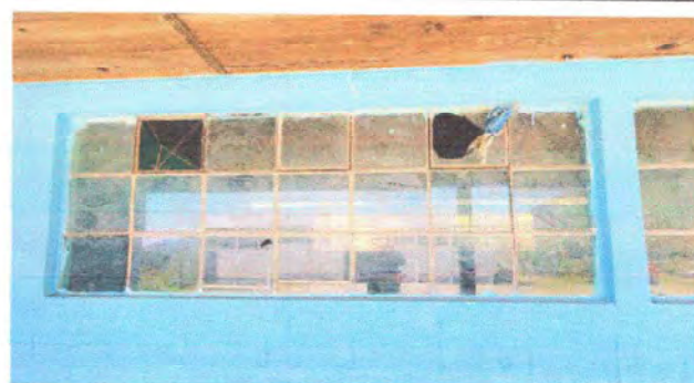
Foto 2: MODULO 1 Sustitución de vidrios
