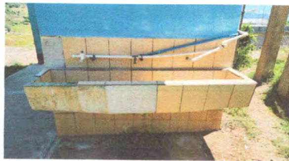
Foto 8: MODULO 3 Sustitucion tuberia linea principal y Grifos
