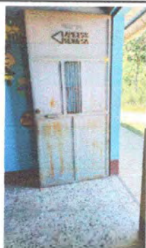
Foto 3: MODULO 2 Mantenimiento a estructura de puerta (lijado, cambio de tubo, cepillado, sujeciones, aplicación de pintura)
