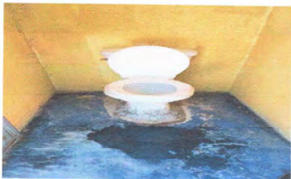
Foto7: MODULO 3 Sustitución de Inodoro
