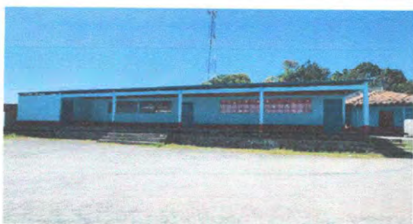
Foto 9: Pintura en muros exteriores e interiores
