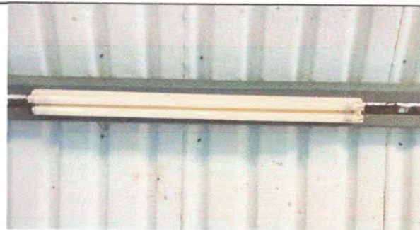
Foto 4: MODULO 2 Sustitución de lámparas de 2 x 40
