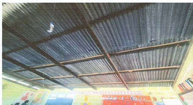
Foto 2: Sustitución de soporte de madera por soporte de metal. Modulo 1
