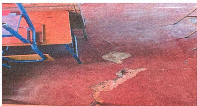
Foto 3. Sustitución de piso de cemento liquido por piso ceramico. Modulo 1
