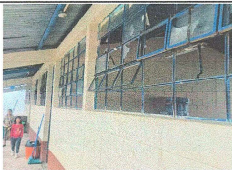
Foto 3: Modulo 1 Fabricación e instalación de balcón de hierro en ventana
