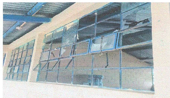
Foto 2: Modulo 1 Sustitucion de vidrios
