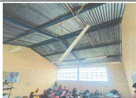
Foto 4: Modulo 1 Reparación de cableado eléctrico.
