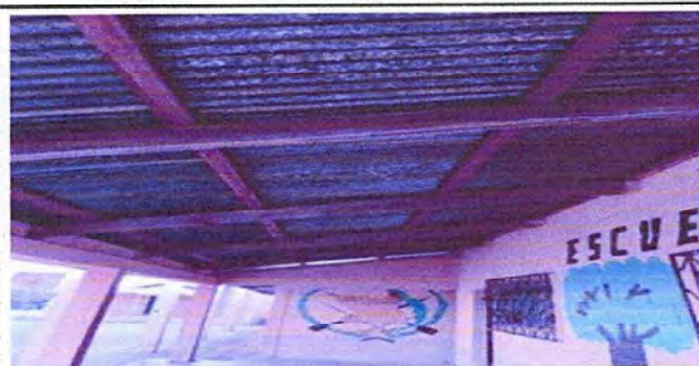
Foto 3: Módulo 1. Sustitución de estructura de soporte de madera por metal.
