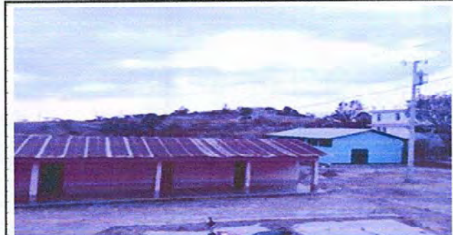
Foto 6: Módulo 2. Sustitución de lamina por lamina troquelada de aluzinc calibre 26.
