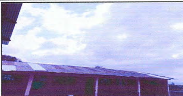
Foto 2: Módulo 1. Sustitución de lamina por lamina troquelada de aluzinc calibre 26
