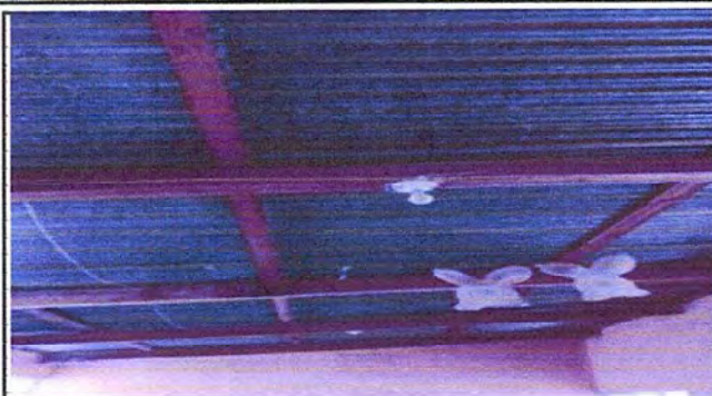
Foto1: Módulo 1. Sustitución de estructura de soporte de madera por metal.
