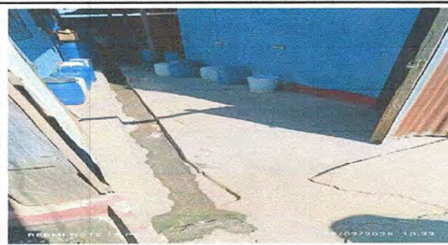
Foto 11: MODULO 1: SUSTITUCIÓN DE DE PORTON DE METAL
