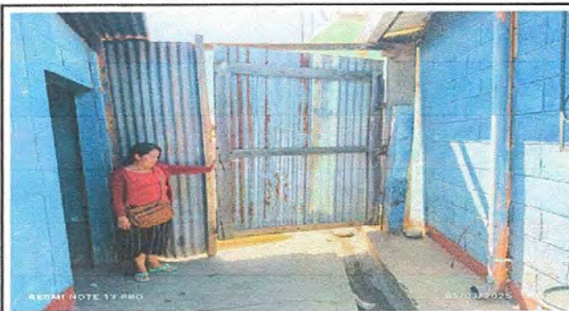
Foto 10: MODULO 1: SUSTITUCIÓN DE DE PORTON DE METAL
