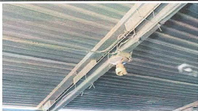
Foto 6: MODULO 1: SUSTITUCIÓN DE FOCO AHORRADORES Y SUSTITUCIÓN DE PLAFONERA
