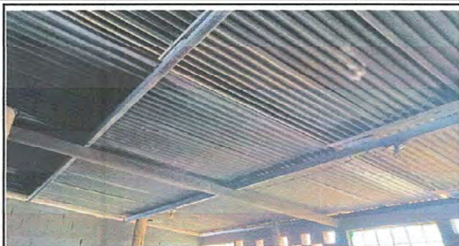
Foto 2: MODULO 1: SUSTITUCIÓN DE ESTRUCTURA PORTANTE
