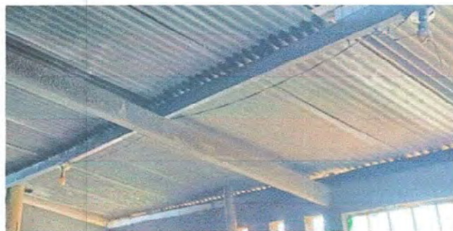
Foto 7: Modulo 1: SUSTITUCIÓN DE CABLEADO ELECTRICO Y DUCTO ELECTRICO+ ACCESORIOS
