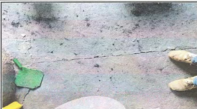
Foto 1: Módulo 1: SUSTITUCIÓN DE PISO DE TORTA DE CONCRETO POR PISO GRANITO
