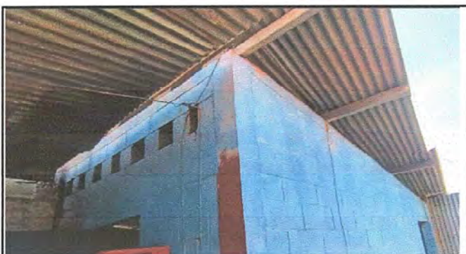
Foto 3: MODULO 1: SUSTITUCIÓN DE LÁMINA POR LÁMINA TROQUELADA ALUZINC CAL. 26
