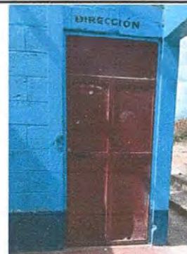
Foto 4, Módulo 1: Sustitución de puerta metal, por puerta metal.
