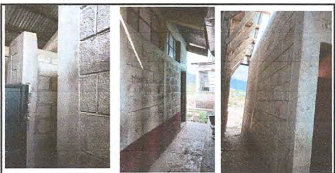
Foto 6, Módulo 2: Pinturas en paredes interiores y exteriores.
