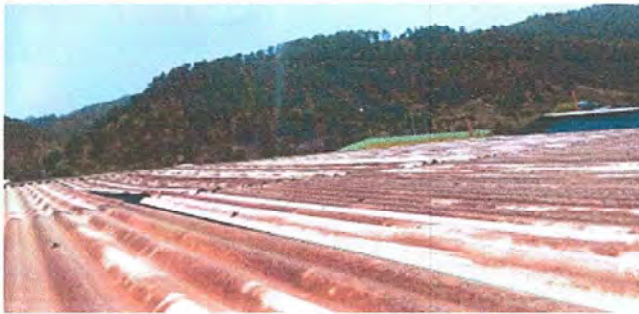
Foto 1, Módulo 1: Sustitución de lámina por lámina troqueladas.
