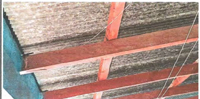
Foto 2, Módulo 1: Sustitución de vigas de madera por tubo cuadrados metal
