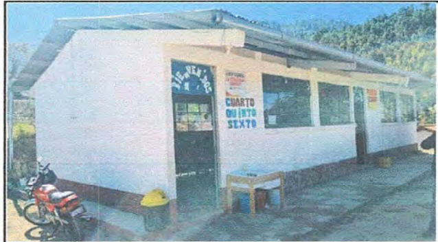
MODULO 01:: Sustitución de lámina, por lámina troquelada aluzinc calibre 26
