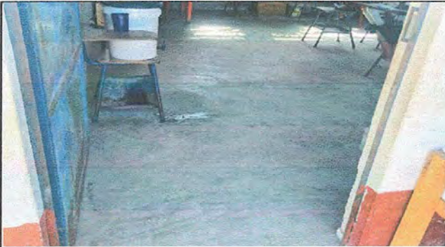
MODULO 01: reparación de piso de torta de concreto por piso cerámico
