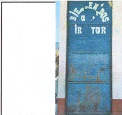
MODULO 01: Mantenimiento a estructura de puerta (lijado, cambio de tubo, cepillado, sujeciones, aplicación de pintura)
