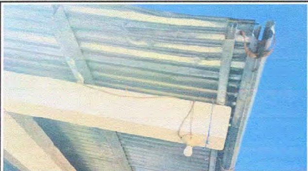
MODULO 01: Sustitución de lamparas tipo LED
