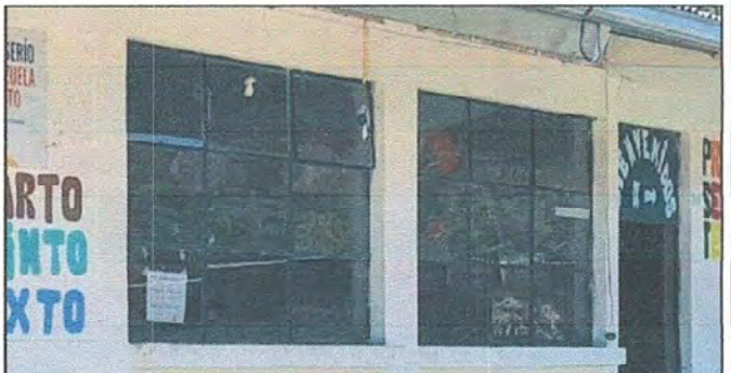
MODULO 01: Fabricación e instalación de balcon de hierro en ventana
