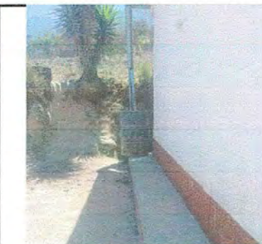
MODULO 01: Sustitución de depósito de agua 1100 lt
