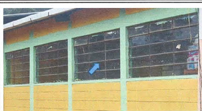
MODULO 01: Fabricación e instalación de balcon de hierro en ventana
