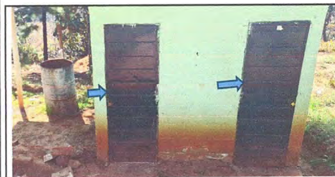
AREAS EXTERIORES: Mantenimiento a estructura de puerta (lijado, cambio de tubo, cepillado, sujeciones, aplicación de pintura) a puertas servicios sanitarios
