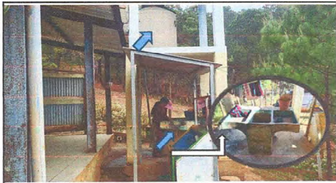
AREAS EXTERIORES: Sustitución de depósito de agua 1100 lt, Sustitución de pila de cemento de dos lavaderos
