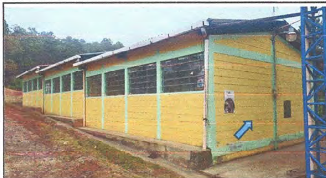
MODULO 01: Pintura en muros exteriores e interiores
