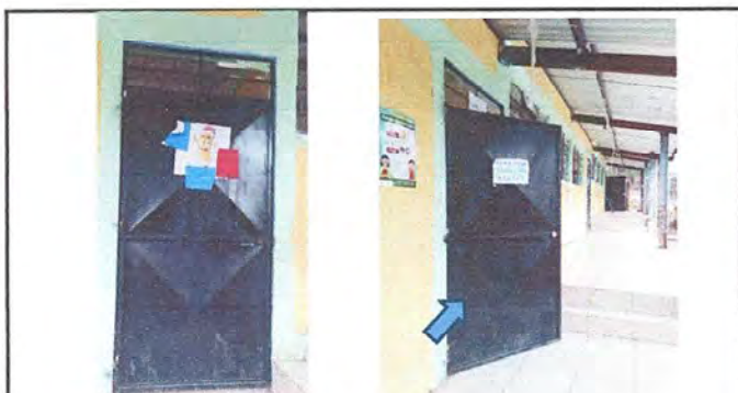
MODULO 01: FOTO 3, Pintura en muros exteriores e interiores
