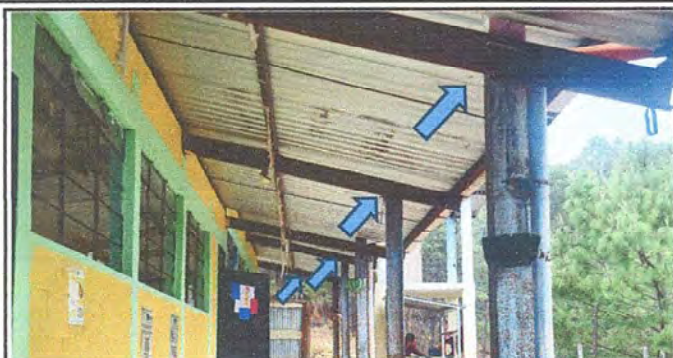
MODULO 01: Mantenimiento a estructura de soporte de metal
