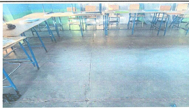
Módulo 1, Foto 2: Sustitución de torta por piso ceramico.
