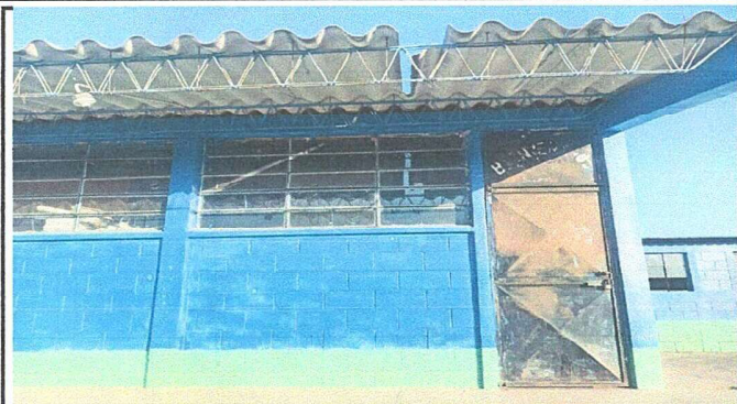
Módulo 1, Foto 1: Sustitución de duralita por laminas y sustitución de dos puertas.
