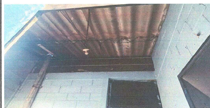
Módulo 1, Foto 3 : Sustitución de láminas.
