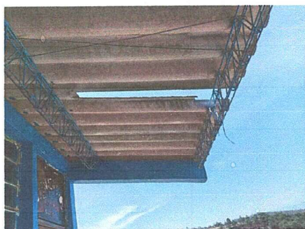
Módulo 1, Foto 4: Sustitución de láminas.
