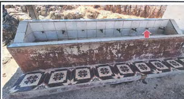
FOTO 14, SERVICIOS SANITARIOS: Sustitución de llave de chorro
