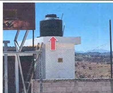
FOTO 16, MURO PERIMETRAL: Sustitución de depósito de agua 1100 lt
