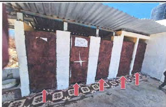
FOTO 13, SERVICIOS SANITARIOS: Mantenimiento a estructura de puerta (lijado, cambio de tubo, cepillado, sujeciones, aplicación de pintura)
