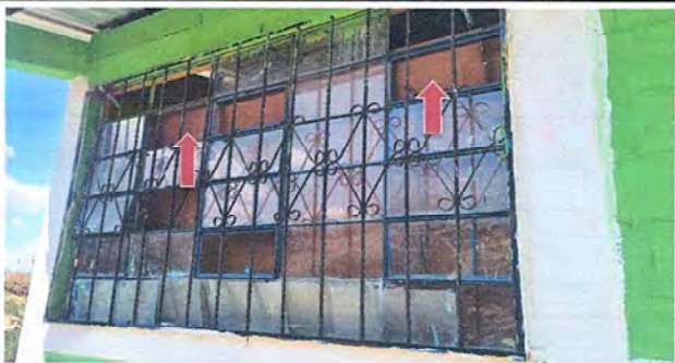
FOTO 3 MODULO 1 : Sustitución de vidrios
