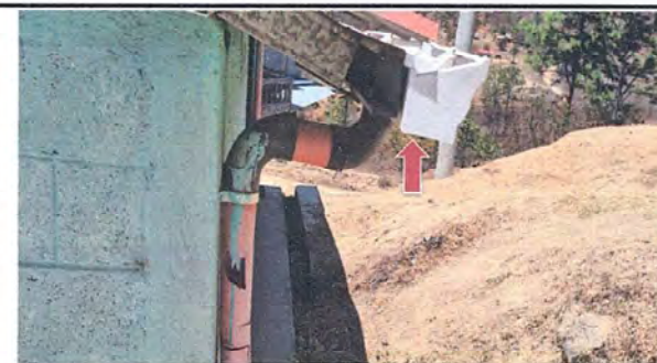
FOTO 6, MODULO 2: Sustitución de canal de pvc
