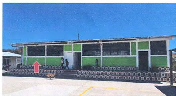
FOTO 1, MODULO 1: Pintura en muros exteriores e interiores
