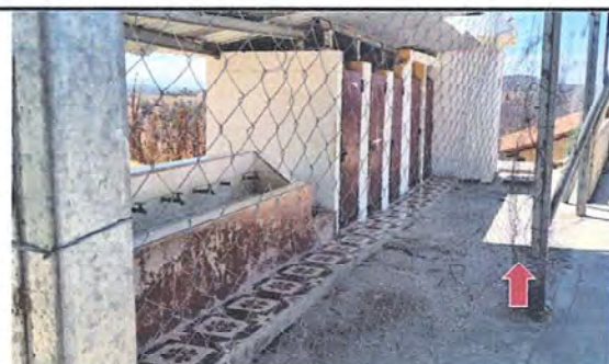
FOTO 17, MURO PERIMETRAL: Reparación de tubo hg y malla galvanizada
