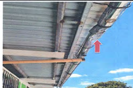
FOTO 4, MODULO 1: Sustitución de canal de metal
