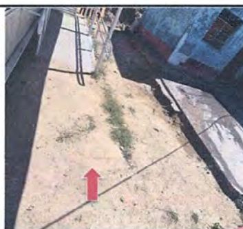
FOTO 18, PATIO: Reparación de piso de patio de torta de concreto
