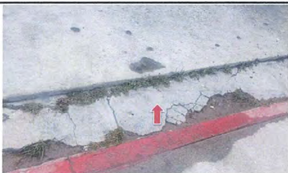
FOTO 19, PATIO: Reparación de cuneta de concreto
