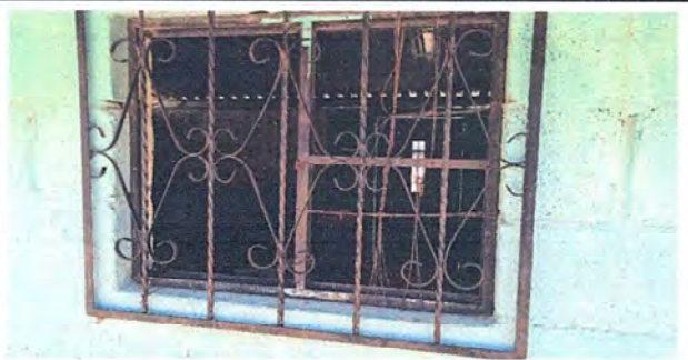
FOTO 5, MODULO 2: Sustitución de ventana de metal
