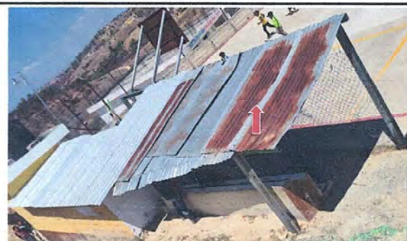
FOTO 15, SERVICIOS SANITARIOS: Sustitución de lámina, por lámina troquelada aluzinc calibre 26
