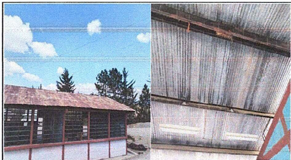
Foto 1: Modulo 1 Sustitución de Lámina por troquelada, mantenimiento a estructura de soporte de metal.
