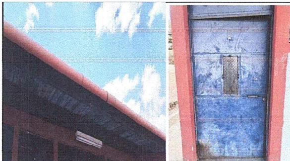
Foto 2: Modulo 1 Sustitución de canal de PVC, Mantenimiento a estructura de Puertas, sustitución de chapa.
