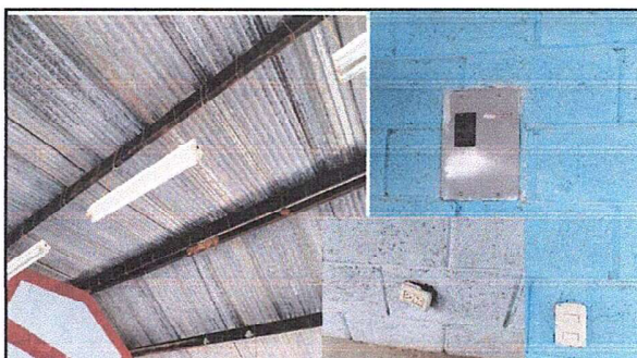
Foto 4: Modulo 1 Sustitución de lamparas, interruptores, ducto, flipones, cable.
