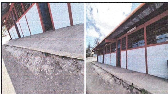
Foto 3: Modulo 1 Reparación de bordillo de concreto reforzado, Pintura en muros exteriores e interiores.
