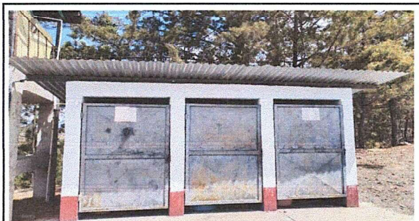
Foto 5: Modulo 2 Pintura en muros exteriores e interiores, mantenimiento a estructura de puertas.
