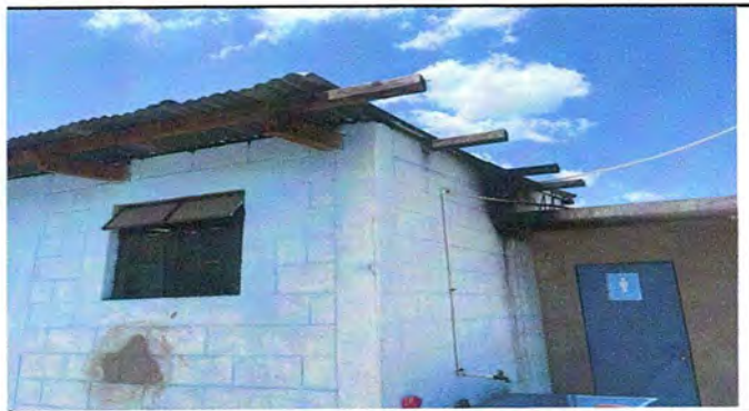
Foto 10: Módulo 3 Cambio de techo completo.
