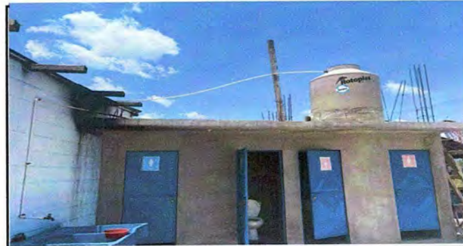
Foto 12: Instalacion de tinaco.
