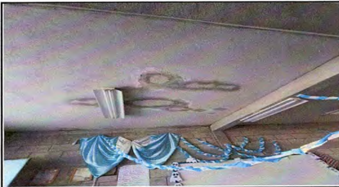
Foto 1: Módulo 1 Impermeabilización de loza
