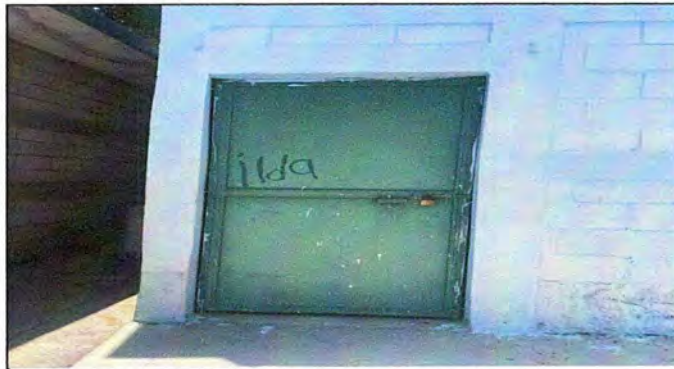
Foto 8: Módulo 2 Mantenimiento de puerta de metal.
