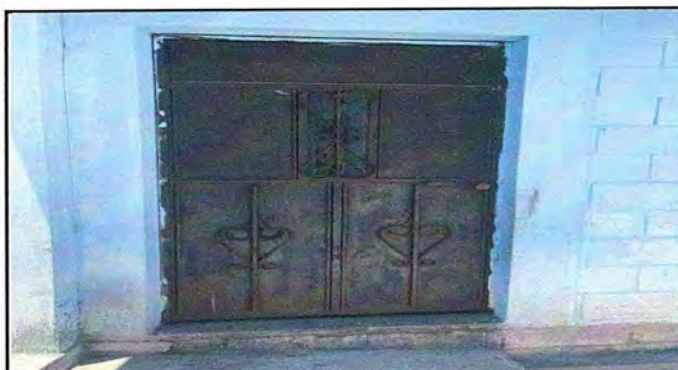
Foto 9: Módulo 3 Mantenimiento de puerta de metal
