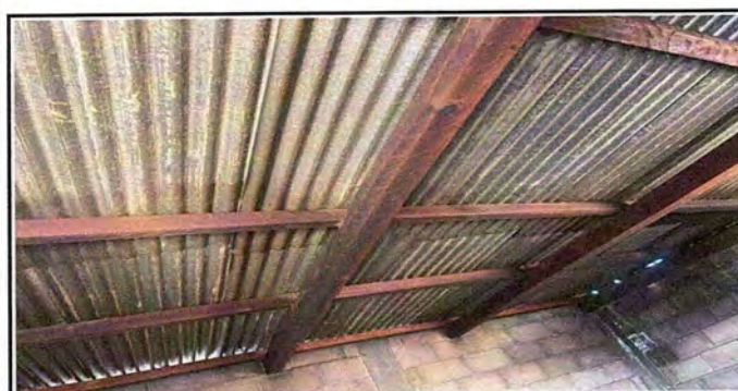
Foto 11: Módulo 3 Cambio de techo de madera por costaneras y cambio de laminas onduladas por lamina troquelada aluzinc calibre 26.
