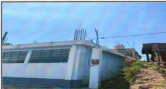
Foto 13: Instalacion de acometida electrica
