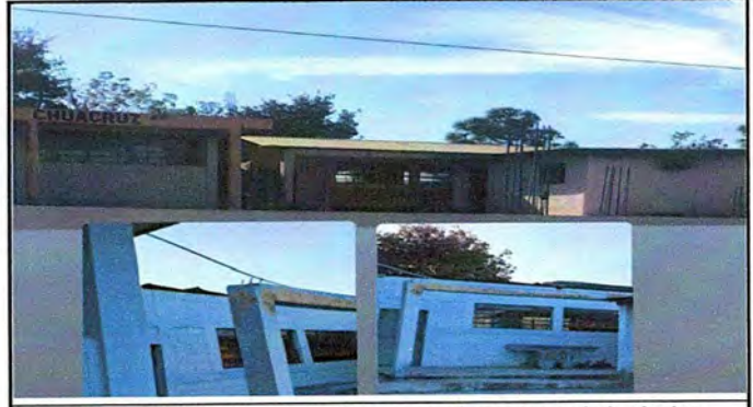
Foto 4: Módulo 2 Sustitución de lámina por lámina troquelada alucinc calibre 26.
