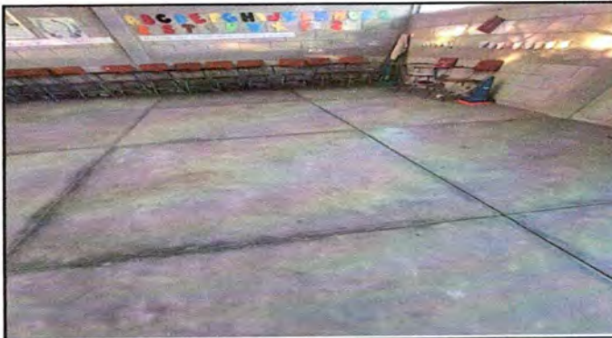
Foto 3: Módulo 1 Sustitución de piso de torta de concreto por piso cerámico.
