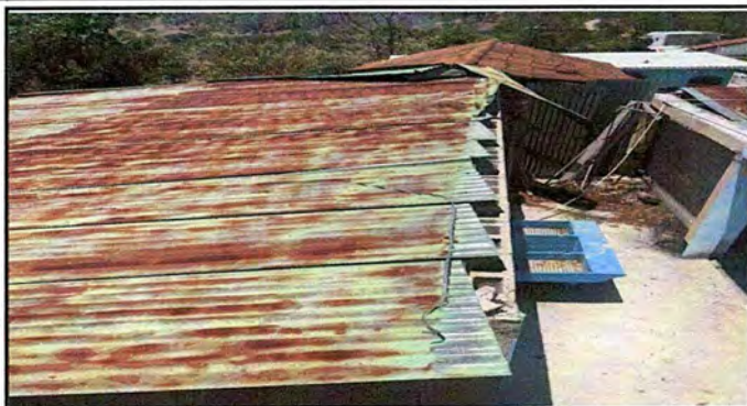
Foto 7: Módulo 2 Cambio de techo completo.
