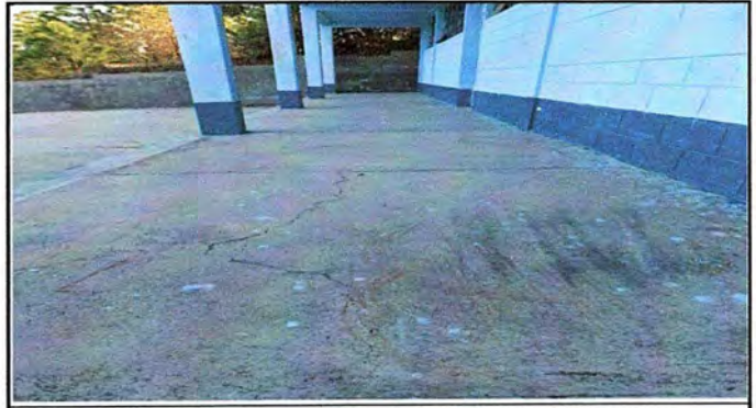
Foto 2: Módulo 1 Sustitución de piso de torta de concreto por piso cerámico.
