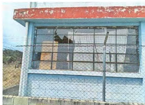
Foto 16: MÓDULO 3 SUSTITUCION DE VIDRIOS
