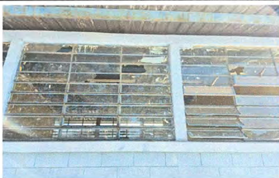
Foto 23: MÓDULO 5 SUSTITUCIÓN DE VIDRIOS
