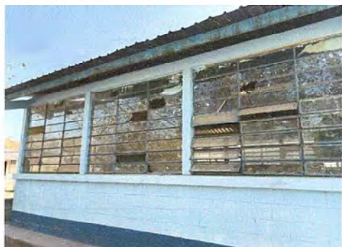
Foto 19: MÓDULO 5 SUMINISTRO E INSTALACION DE BALCONES DE HIERRO EN VENTANAS
