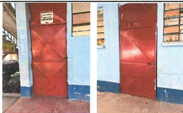
Foto 15: MÓDULO 3 MANTENIMIENTO A ESTRUCTURA DE PUERTAS Y SUSTITUCION DE CHAPAS
