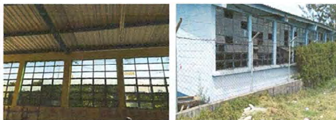
Foto 18: MÓDULO 4 SUSTITUCION DE VIDRIOS
