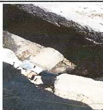
Foto 2: MÓDULO 1 SUSTITUCIÓN E INSTALACIÓN DE TUBERÍA PVC LINEA PRINCIPAL AGUAS NEGRAS
