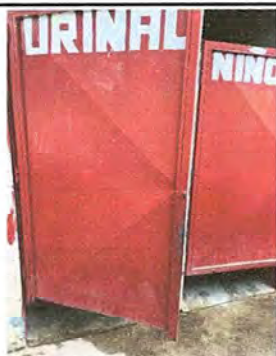
Foto 9: MÓDULO 1 MANTENIMIENTO A ESTRUCTURA DE PUERTAS
