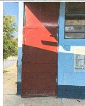
Foto 20: MÓDULO 5 SUSTITUCION DE CHAPAS Y MANTENIMIENTO A ESTRUCTURA DE PUERTAS
