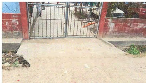
Foto 24: MÓDULO 24 REPARACION DE PLANCHAS DE CONCRETO ENTRADA PRINCIPAL
