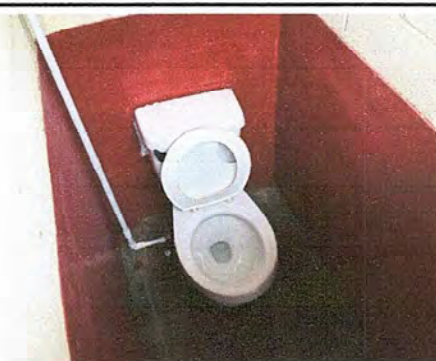
Foto 4: MÓDULO 1 SUSTITUCIÓN DE INODORO
