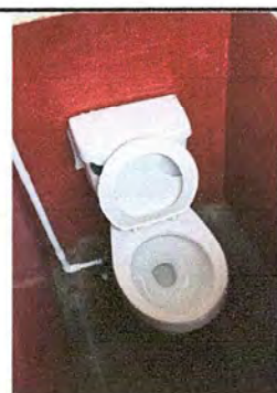
Foto 5: MÓDULO 1 SUSTITUCIÓN DE INODORO
