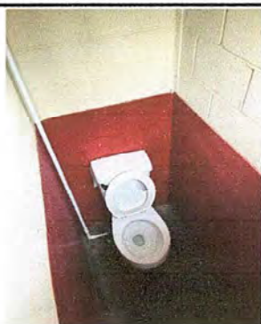
Foto 3: MÓDULO 1 SUSTITUCIÓN DE INODORO
