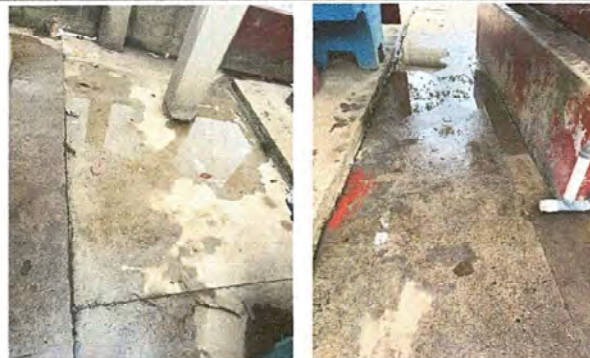
Foto 8: MÓDULO 1 REPARACIÓN DE PLANCHAS DE CONCRETO
