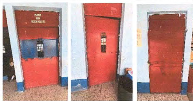
Foto 12: MÓDULO 2 SUSTITUCIÓN DE CHAPAS DE PUERTAS Y MANTENIMIENTO A ESTRUCTURA DE PUERTAS
