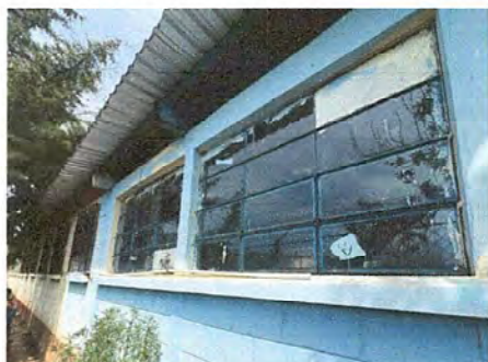
Foto 13: MÓDULO 2 SUSTITUCION DE VIDRIOS
