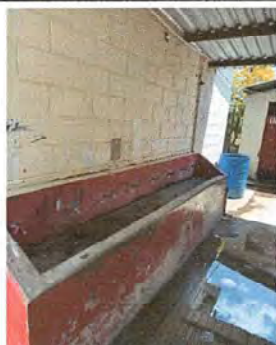
Foto 7: MÓDULO 1 SUSTITUCIÓN E INSTALACIÓN DE CHORROS
