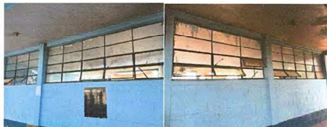
Foto 14: MÓDULO 3 SUMINISTRO E INSTALACIÓN DE BALCONES DE HIERRO EN VENTANAS
