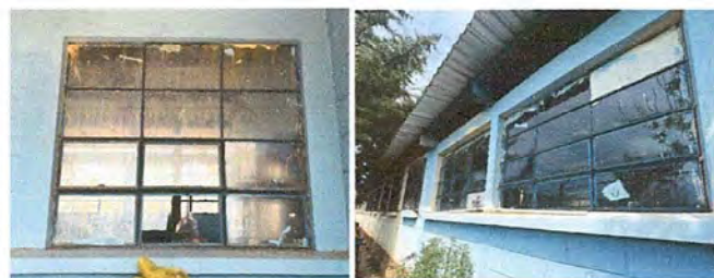
Foto 10: MÓDULO 2 SUMINISTRO E INSTALACION DE BALCONES DE HIERRO EN VENTANAS
